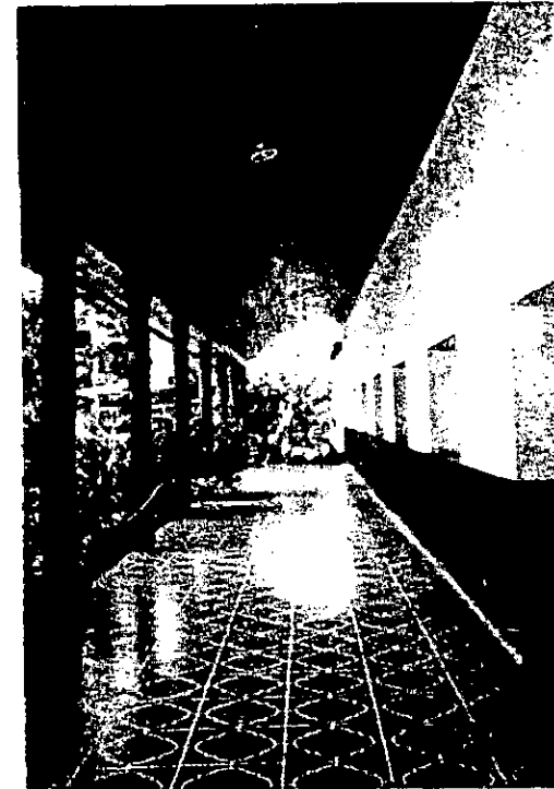
4. PASILLO EN FACHADA OESTE, EL PISO FUE SUSTITUIDO POR UNO DE GRANITO Y COLUMNAS DE CEMENTO
