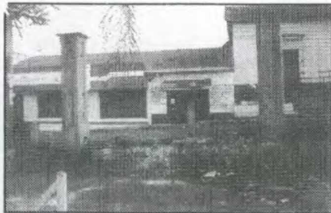
Foto No.32: Falta de mantenimiento del lugar crea descomposición visual como social.
