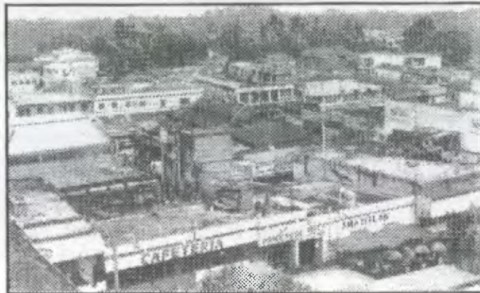
Foto No.28 : se puede observar la alteración de la arquitectura del contexto inmediato a la iglesia.
