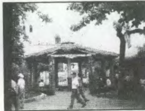
Foto No. 2 vista de un kiosco de la plaza en mal estado
