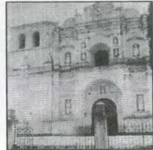
Foto No.37 la fachada principal junto con el campanario
