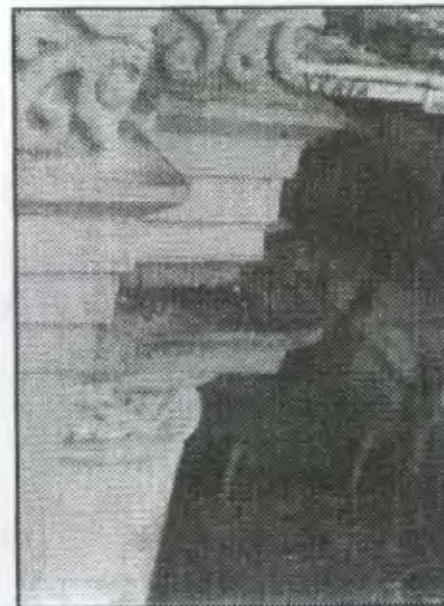
Foto No.61 Se puede observar como las palomas dañan severamente las cornisas y toda la estructura con los excrementos que se combinan con condiciones climáticas para deteriorar aun más los materiales de acabados principalmente
