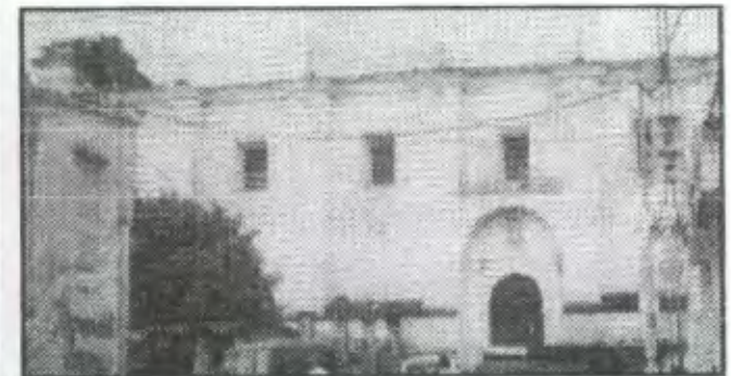
Foto No.39a. la fachada lateral Este
