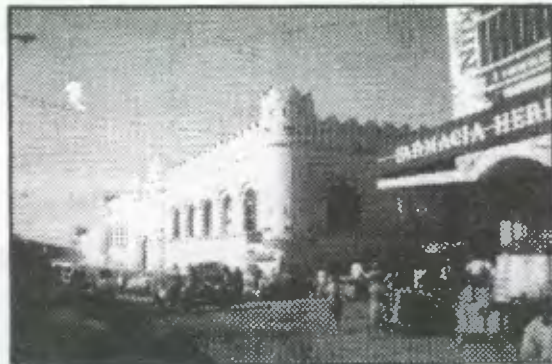
Foto No. 24 edificio de la policia nacional civil también afectado por el entorno
