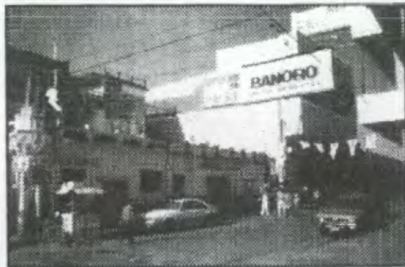
Foto No. 19 edificios y rótulos mal planificados por la falta de normas en el área
