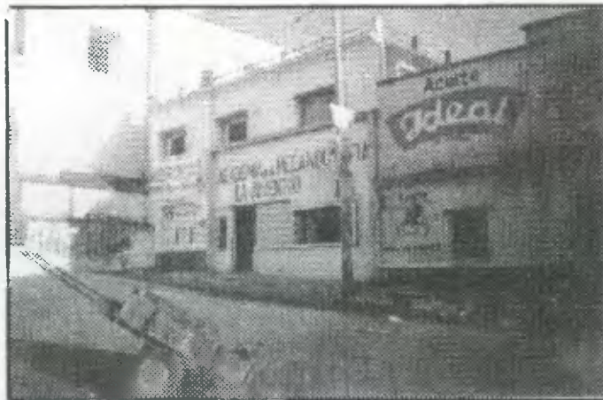
Foto No.29 : Se observa la falta de integración y el daño visual como constructivo que provoca Esta edificación.
