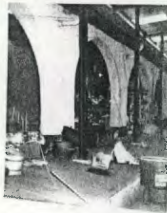
Foto N. 17 Vista del Patio Central. (Techado con estructura metálica Provisional).
