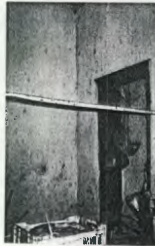
Foto N. 40 Poliducto expuesto en la parte superior de los Muros.
