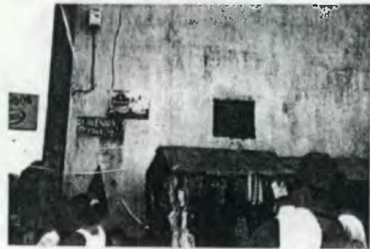
Foto N. 29 Desprendimiento de repello en muros.
