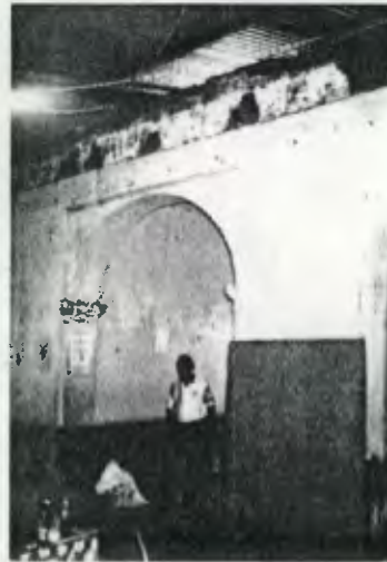
Foto N. 14 Arco ubicado al final del corredor de ingreso al edificio.
