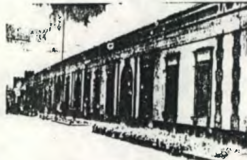
Foto N. 4 Revista Monográfica ,Escuintla 1970 Vista del Edificio Municipal, después del terremoto de 1942, en el que se destruyó la torre de la parte central del edificio.
