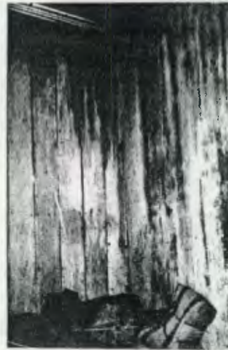
Foto N 21 División de tablones de madera para separar el mercado del edificio municipal.
