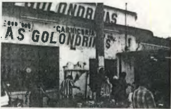
FOTO N.22 SE PUEDE OBSERVAR EL LOCAL UBICADO EN LA 3a. AVENIDA ENTRE 9a. Y 10a. CALLE EL CUAL HA SIDO MODIFICADO PARA SER UTILIZADO COMO CARNICERIA.
