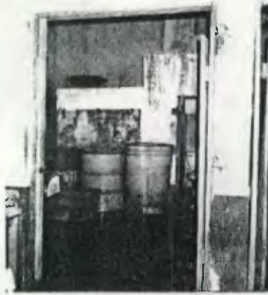
Foto N. 18 Detalle de estado actual de instalación de agua potable e ingreso a los servicios sanitarios.
