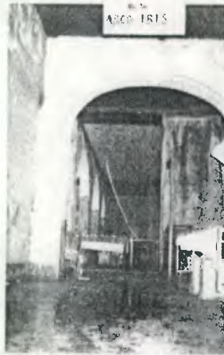
Foto N. 31 Area de ingreso ubicado sobre la 3a Av Agregado de block sobre arco de mampostería.
