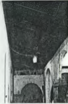
Foto N. 41 Cables de instalación eléctrica, en techo, para dotar de iluminación en el corredor y otras áreas.
