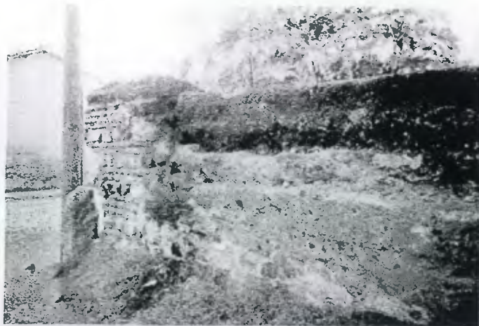
Foto A26. Muros de mampostería alternados con tapial y guardacantón rústico ubicados en la esquina nor-poniente de la finca el Desengaño, 1999. Fuente : JMSM
