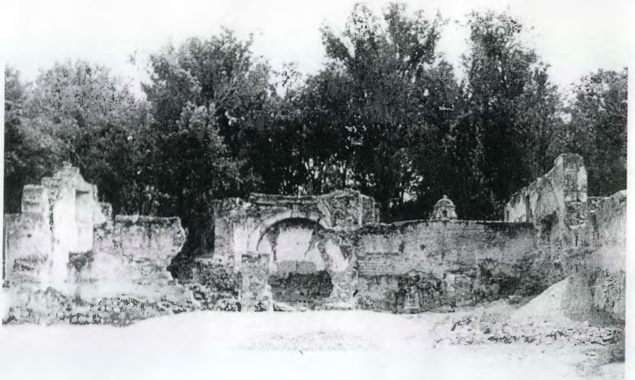
Foto 7. Vista desde el sur de la ermita de San Jerónimo. Véase al extremo derecho el muro testero y la impronta de la cubierta a dos aguas de la nave de la ermita, 1973. Fuente CNPAG.
