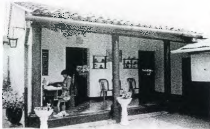
Foto A7. Vivienda colonial probablemente perteneciente al barrio de Santiago. Los pilares de madera fueron sustituidos por columnas de concreto (ver fotos A8, A9 y A12 que son de la misma vivienda), 1999. Fuente : JMSM
