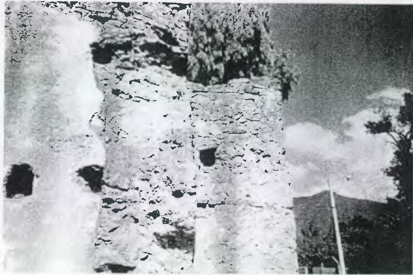
Foto 22. Los dos mechinales ubicados a la izquierda corresponden a un entrepiso de madera mientras que los que se ubican a la derecha probablemente correspondieron a un pequeño campanario, 1999. Fuente : JMSM
