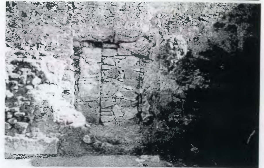
Foto 16. Vano de puerta tapiado en el sector norte de la nave de la ermita de San Jerónimo. Esta puerta comunicaba a la sacristía, 1998. Fuente: JMSM
