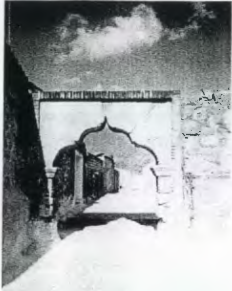
Foto A18. Arco conopial perteneciente a una vivienda colonial, ubicada aproximadamente a 50 metros al sur del que fuera el Colegio de San Jerónimo, 1999. Fuente : JMSM
