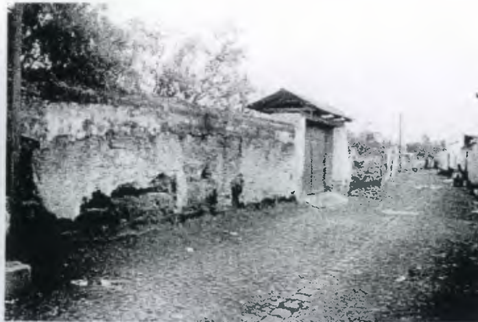
Foto A27. Calle irregular perteneciente al barrio de San Antón, 1999. Fuente : JMSM
