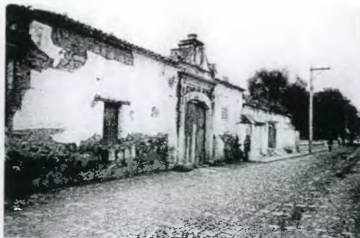
Foto A5. Ingreso principal de la casa Landívar. Esta vivienda perteneció a uno de los barrios mercedarios (probablemente al del Espíritu Santo), 1999. Fuente : JMSM
