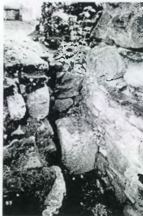
Foto 18. Basa de piedra en el sector sur de la nave de la ermita. Probablemente aquí existió un acceso lateral a la ermita, 1998. Fuente: JMSM
