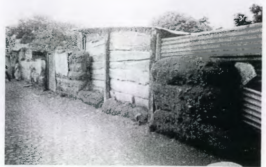
Foto A30. Vestigios de muros construidos con adobe ubicados en el poniente de La Antigua Guatemala, 1999. Fuente : JMSM
