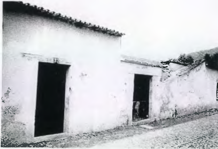
Foto A29. Vivienda ubicada al poniente de La Antigua Guatemala. Nótese los dinteles de madera en las puertas, 1999. Fuente : JMSM
