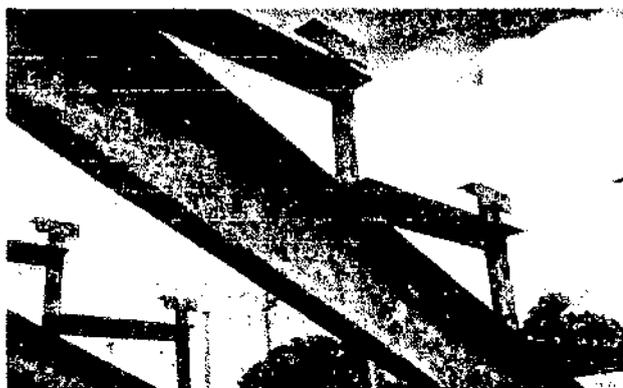
10. Detalle del grado de oxidación en las vigas y armado del graderío, se aprecia la ausencia total de la base de madera que servía de asiento a los espectadores.
