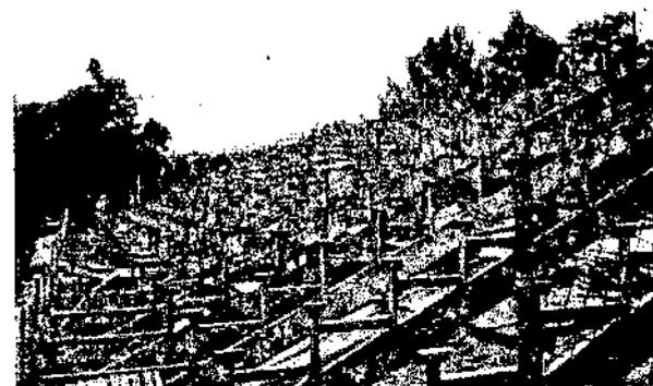
5. Vista general de la estructura del graderío, en la parte baja se aprecia el corredor o circulación y el área de asientos en la parte superior con un total de 14 filas.
