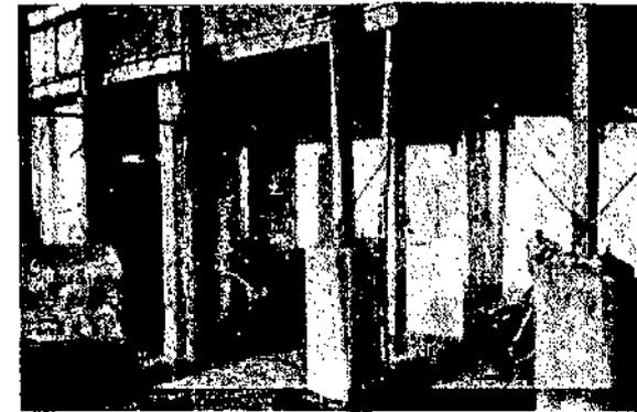
2. Detalle de la fachada de los camerinos de los corredores, se aprecia la base de columna y la continuación de columna metálica con breizas de hierro.
