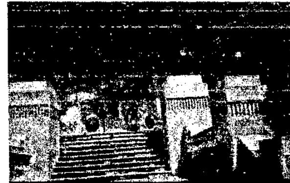
27. Vista de las escalinatas hacia el tramo central, se aprecia los detalles de mármol, las esferas de cristal y la formación de hongos en las contrahuellas.
