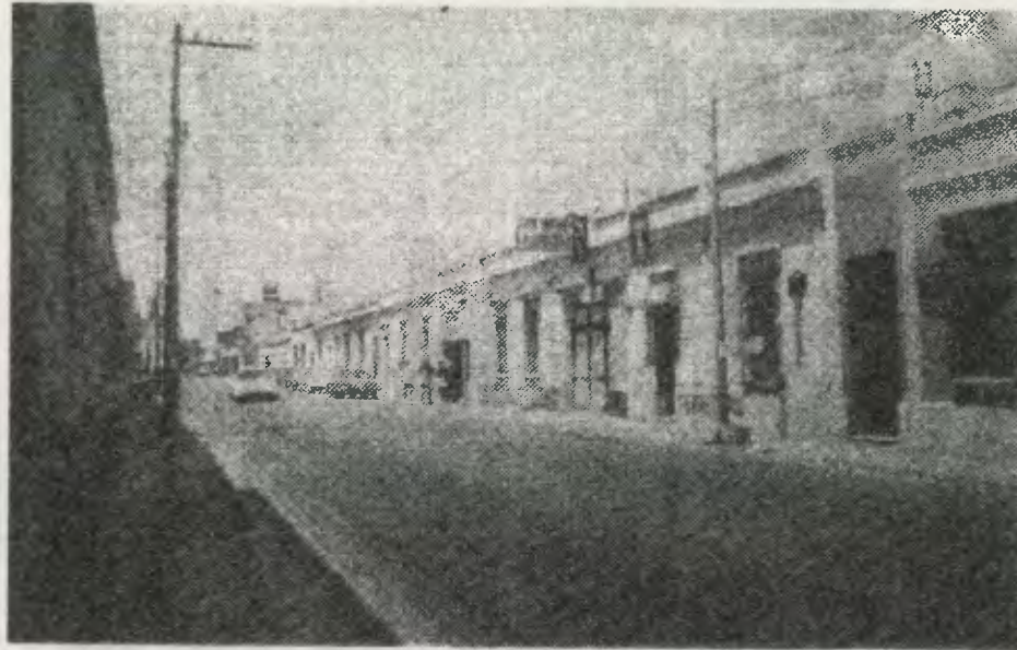
FOTOGRAFIA No. 3. Vista hacia lado norte sobre la 10ma. Avenida
