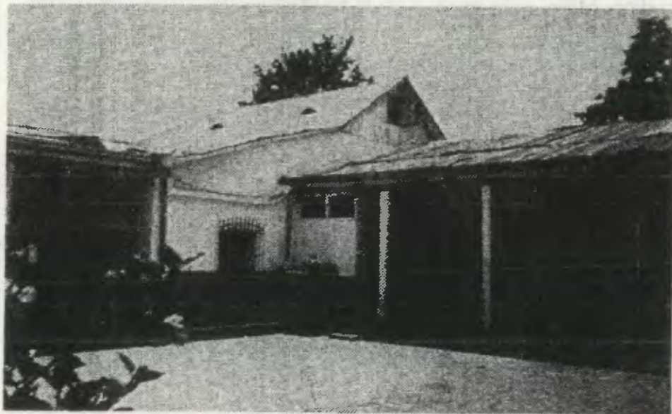
FOTOGRAFIA No. 3. Vista hacia capilla y s.s. Docentes desde el claustro.
