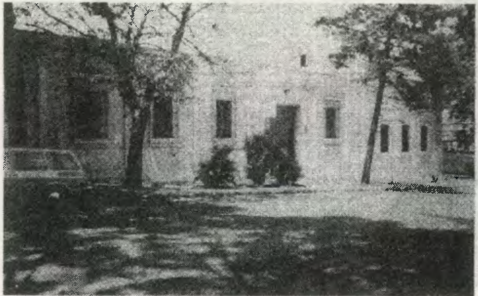
FOTOGRAFIA No. 8. Vista hacia lado norte del edificio desde lado sur sobre la 1ra. calle
