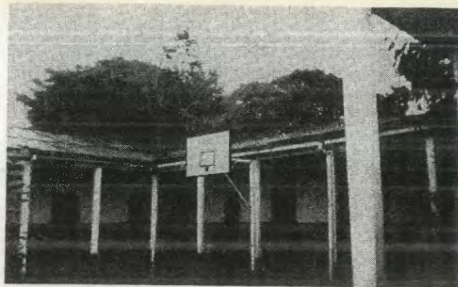
FOTOGRAFIA No. 2. Vista del claustro , solución dada para la practica deportiva.
