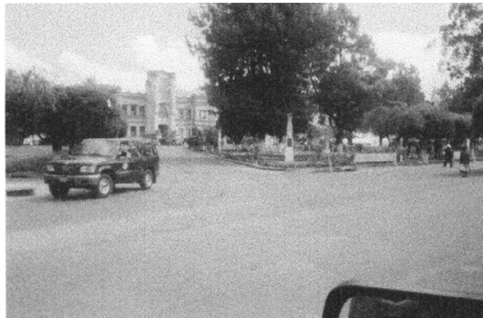
FOTO No. 11 NUDO No. 6 DESDE CALZADA REV. DEL 71.
