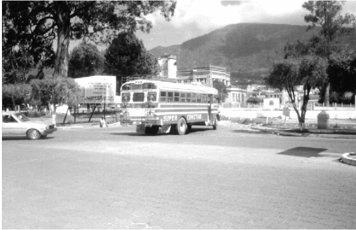
FOTO No. 13 NUDO No. 8 DESDE CALZADA REV. DEL 71.
