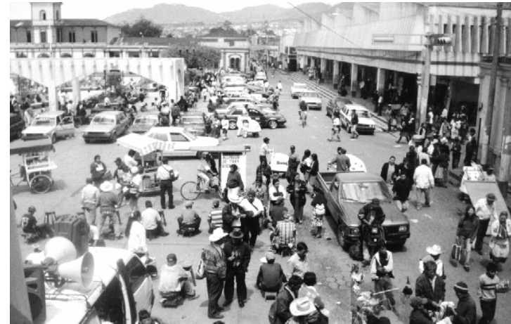
FOTO No. 28 NUDO No. 23 DESDE CENTRO COMERCIAL No. 2.
