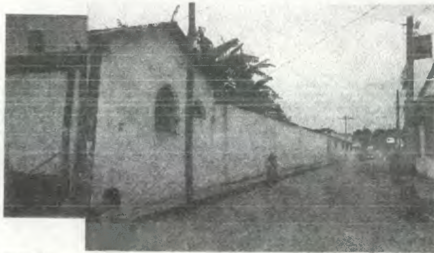
Fotografía 14 -bloque 5- fachada sur.
