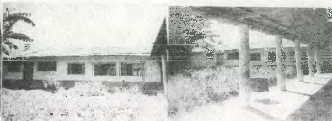
Fotografía No. 17, muestra la fachada interior de la casa parroquial -Lado Sur-
