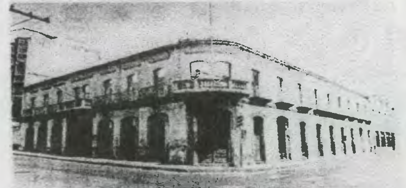
Edificio de esquina 8ª avenida y 10ª calle. Foto 1986
