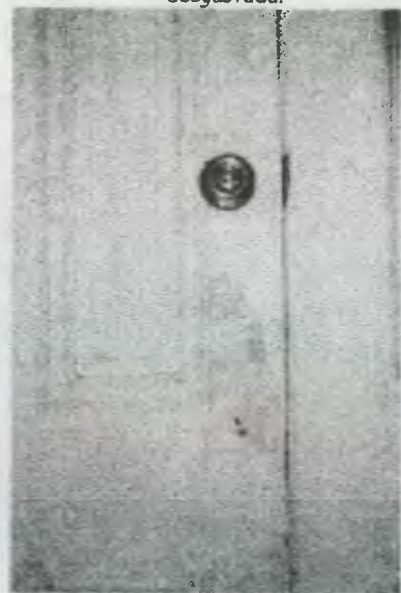
FOTO 8 9 se muestra el evidente deterioro y abandono que sufren algunas de las puertas interiores del edificio, en cuanto a presencia de microflora y desprendimiento de la pintura.
