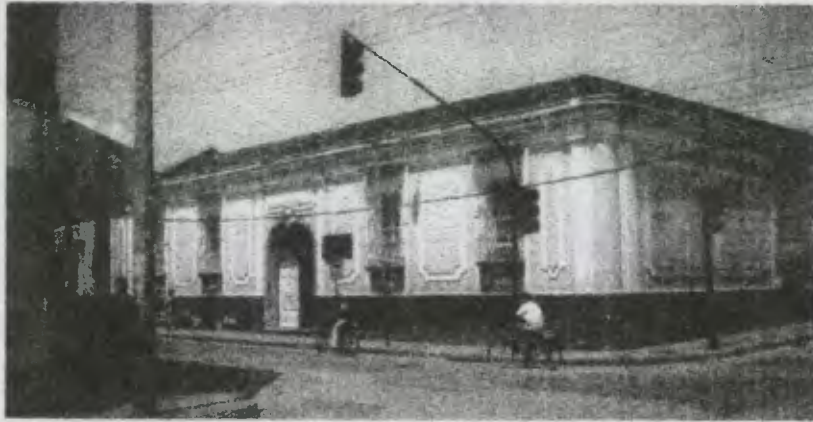
FOTO 1 Se muestra la fachada del juzgado, se aprecia que la parte baja de las paredes aunque está de un color más oscuro está manchada, se aprecia el nuevo sistema de semáforos en el sector.
