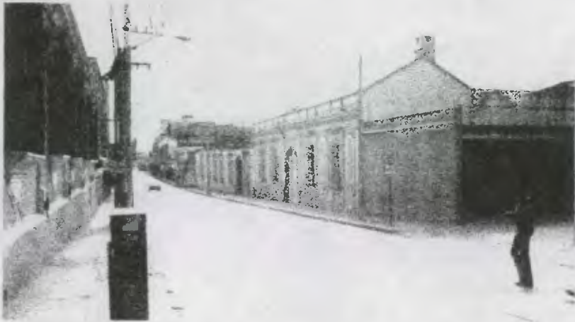
FOTO 1. Vista sobre la 13 calle, se observa la demolición de edificios y del uso el lote para Parqueo..
