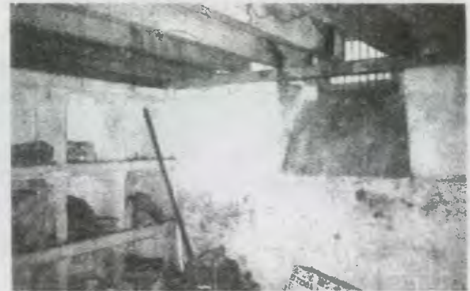
FOTOS 43 44 son dos vistas de un pequeño sótano que en algún tiempo sirvió de alacena y cava de vinos y que actualmente se encuentra con presencia de basura, restos de bolsas de cemento y algunas tejas. Se observa que sus paredes están afectadas por la humedad, microflora y sales y las vigas de madera se encuentran deterioradas, ya que sufren de filtraciones de agua y falta de mantenimiento.
