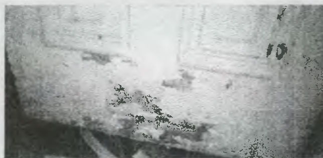
FOTO 8 9 se muestra el evidente deterioro y abandono que sufren algunas de las puertas interiores del edificio, en cuanto a presencia de microflora y desprendimiento de la pintura.
