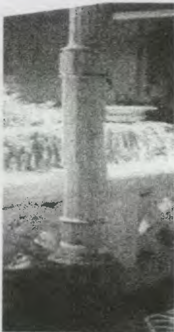
se muestra la base de piedra de la columna, de planta octogonal.
