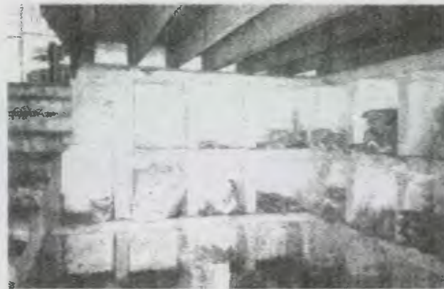
FOTOS 43 44 son dos vistas de un pequeño sótano que en algún tiempo sirvió de alacena y cava de vinos y que actualmente se encuentra con presencia de basura, restos de bolsas de cemento y algunas tejas. Se observa que sus paredes están afectadas por la humedad, microflora y sales y las vigas de madera se encuentran deterioradas, ya que sufren de filtraciones de agua y falta de mantenimiento.
