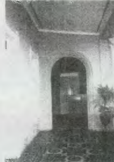
FOTO 31 vista del final del corredor y área que comunica a la parte social con la parte privada del edificio. se observa como se ha tapiado ese vano.
