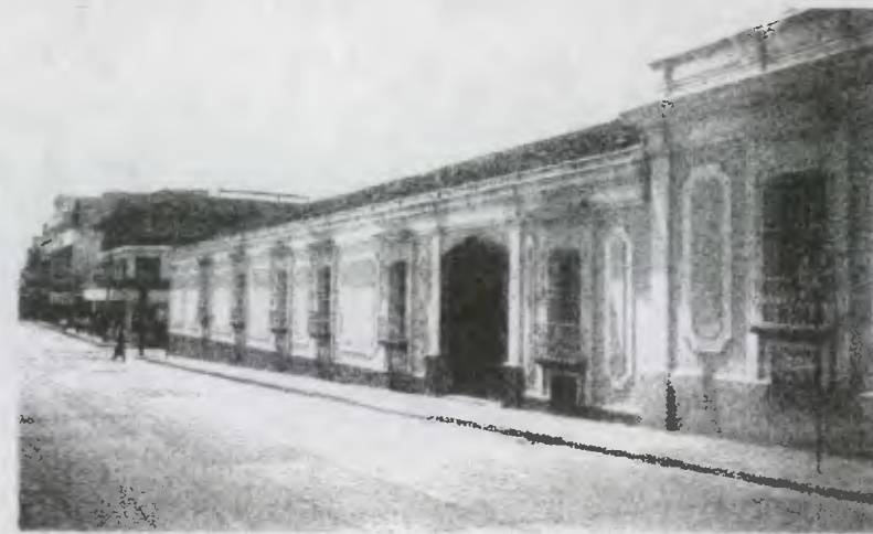
FOTO 2. Vista de la fachada sobre la 13 calle, de nuestro objeto de estudio, donde se aprecia manchas sobre la parte inferior de las paredes, así como los letreros, puestos a media banqueta
