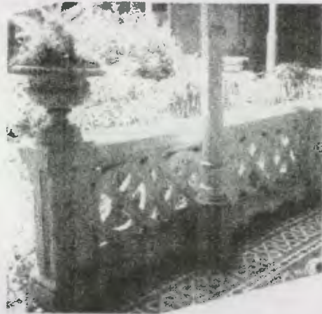
detalle del balaustrado que rodea el patio.
