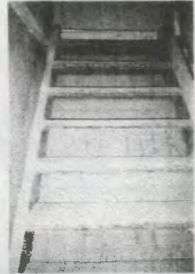
FOTO 40 41 se observa el módulo de escaleras, que en su primer tramo son fundidas de concreto con huellas forradas de granito y en el segundo tramo se aprecia que se cambian por unas de madera más empinadas y se observa que la madera de éstas, se encuentra deteriorada y con presencia de microflora y hongos
