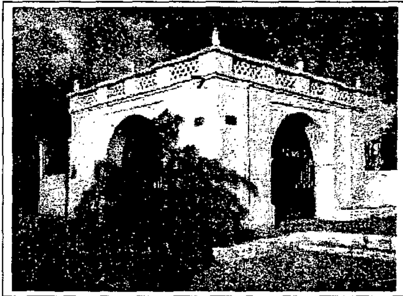
Fotografía Capilla Posa, Barrio de San Pedro Mártir, zona 4
