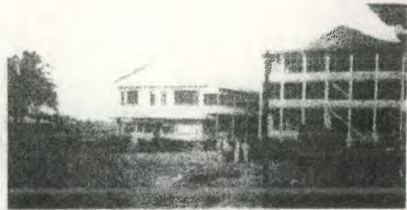
A la izquierda el Edificio de Bandegua ( antes comisariato Bananero), derecha el Edificio de la Policía Nacional objeto de estudio de esta investigación. (Almacén de la UFCo.).
