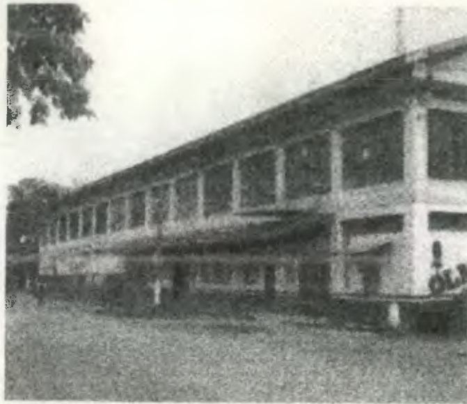
FOTO 1. Vista de la elevación Norte, del edificio de Bandegua sobre la 7a. Calle, sistema constructivo block, concreto armado, cerramiento de puertas y ventanas de madera y metal, cubierta de lamina de zinc con estructura metálica.
