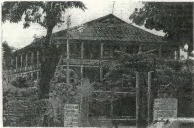
Edificio de la Policía Nacional de Puerto Barrios
