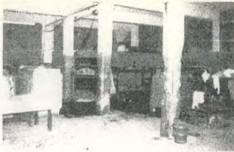
11. Interior de la cárcel, donde se observa una columna a la cual le fue quitado el recubrimiento de concreto quedando a la vista los refuerzos, además que a uno de estos le cortaron una sección.
