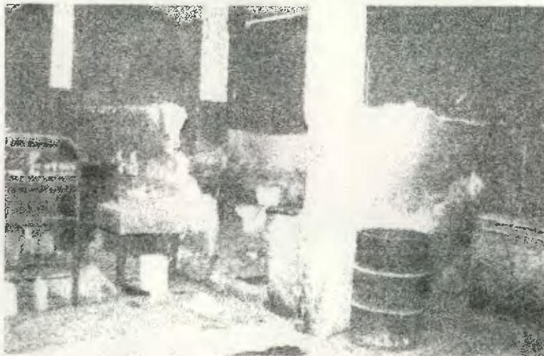
11. Interior de la cárcel, donde se observa una columna a la cual le fue quitado el recubrimiento de concreto quedando a la vista los refuerzos, además que a uno de estos le cortaron una sección.
