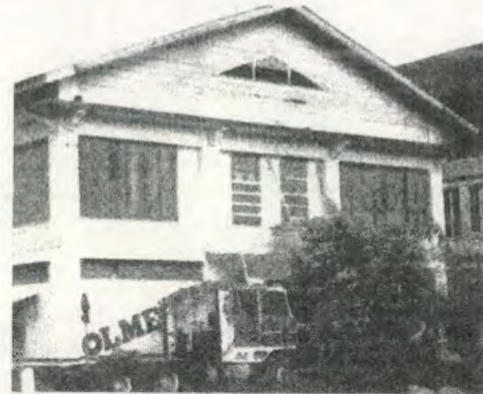
FOTO 2. Vista de la elevación Oeste, frente a esta se observa el deposito de chatarra.
