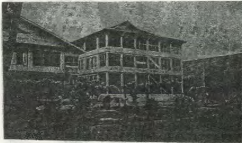
Edificio de la Policía Nacional de Puerto Barrios
