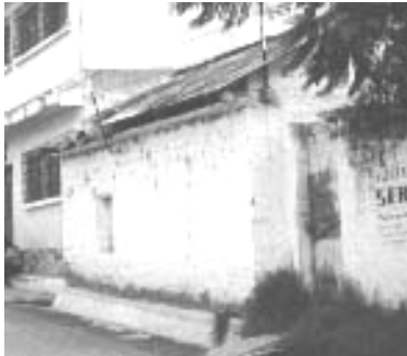
Fotografía No. 7 Esta vivienda es un caso atípico de las viviendas de Santa Catarina Pinula, pues no se encuentra elevada sobre el nivel de la calle. Fuente Propia
