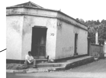
Fotografía No. 14 Esta vivienda es de construcción de adobe combinado con el uso de lámina como cubierta. Fuente Propia
