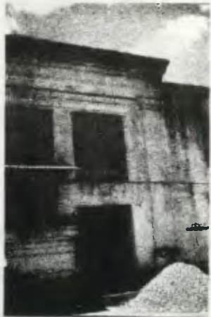
Vista de muro exterior de bodega, existen manchas, inst. expuesta, abertura de puerta para persiana metálica, voladizo lámina en ventana.
