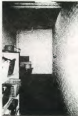
Vista de muro exterior de bodega, existen manchas, inst. expuesta, abertura de puerta para persiana metálica, voladizo lámina en ventana.
