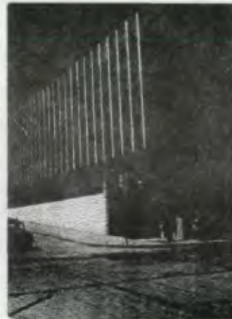
1980 Fachada sobre la 9a calle de la Escuela de Niñeras.
