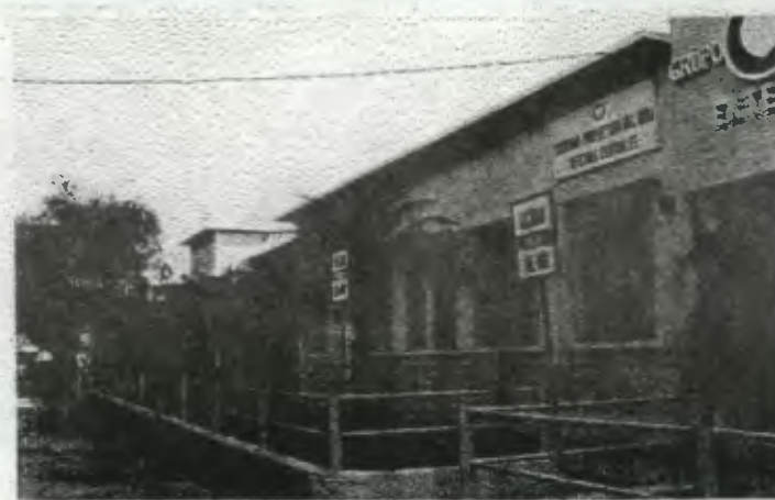
1988 En la misma fachada, se puede apreciar que se agregó protección a las jardineras, con tubo de metal y un muro de dos hiladas de block, los mismos pintados de amarillo con pintura de aceite.
