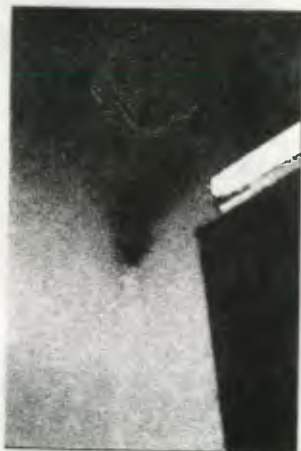
Vista muro en área administrativa. Se observa mancha por humedad que existe en cielo falso, se agregó lámpara de neón en ventana.
