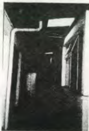
Vista de pasillo para comedor y bodega de cocina. se selló puerta del pasillo. inst. hidráulicas expuestas, cubierta improvisada, para pasillo.
