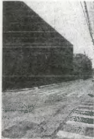
FOTO No. 01 Edificios con volumetría que compite con el Palacio de Comunicaciones
