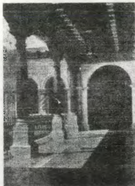
FOTO No. 76 Corredor del 2º Nivel, observándose las columnas de madera con su basa de piedra tallada.
