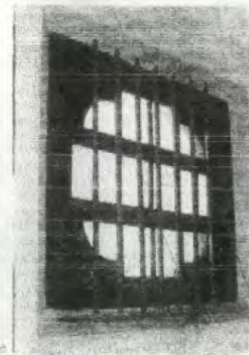
FOTO No. 183 Herrería agregada a la ventana para brindar mayor seguridad.
