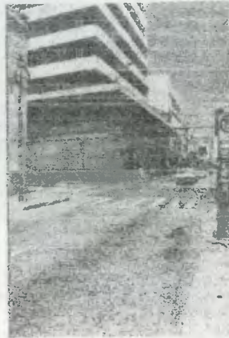
FOTO No. 18 Vista del Edificio Panamericano, otro de los edificios que rompen con el entorno, por su volumen.
