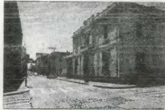
FOTO No. 02 Vista de algunos edificios que si se adaptan al entorno histórico. Se observa el deterioro visual del cableado eléctrico.
