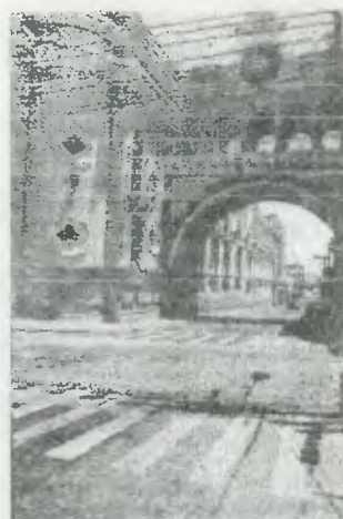
FOTO No. 10 Vista del monumental Arco en día despejado y sin el deterioro visual del comercio informal.
