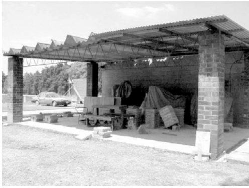
Foto 9: El área de máquinas sirve para almacenar equipo diverso y elementos ensayados.
