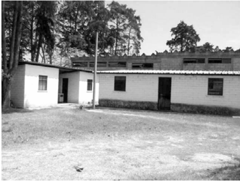
Foto 1: Bodegas de equipo sin uso de la Sección de Metales del Centro de Investigaciones de Ingeniería –CII-. En la parte posterior se aprecia edificio perteneciente al área de Mantenimiento y Servicios Generales.
