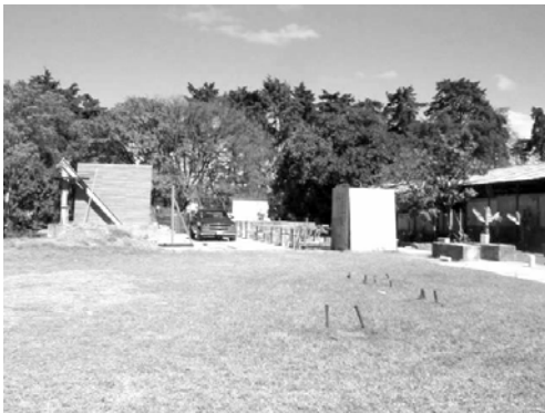
Foto 15: Área para pruebas de muros, vigas y postes.
