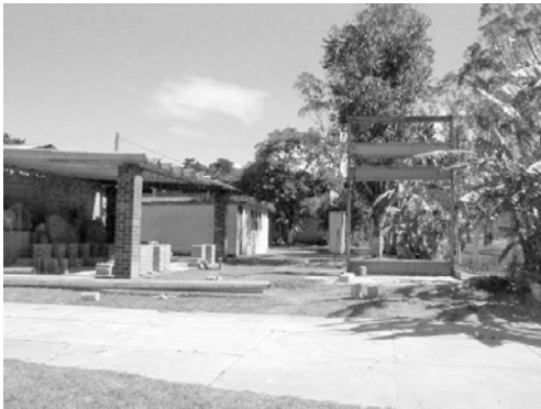
Foto 14: Muro de carga el cual es utilizado para la realización de pruebas a compresión de diversos elementos.
