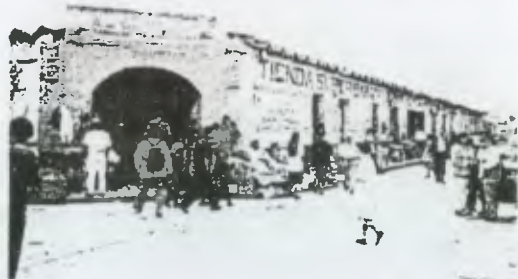
FOTO 10 MERCADO CENTRAL DE HUEHUETENANGO ZONA 1 Y SU DESBORDAMIENTO
