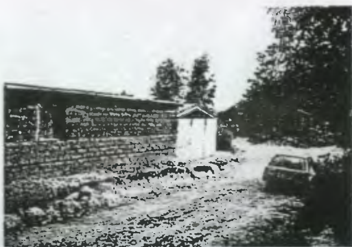
FOTO 7 -TIPOLOGÍA Y TECNOLOGÍA- CONSTRUCCIÓN MIXTA. LEVANTADO DE ADOBE Y CUBIERTA DE LÁMINA DE ZINC
