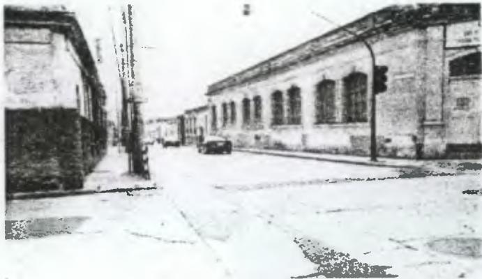
Foto No.3 se aprecia el deterioro que existe en las calles, varios postes cableados frente a la Casa del Niño, así como semáforos y rótulos.
