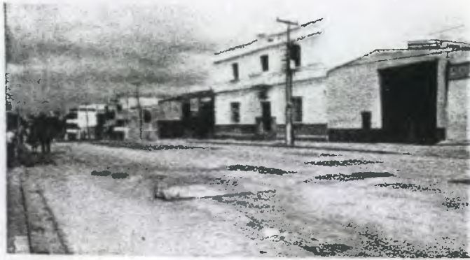
Foto No. 21 Esta es la Calle de Candelaria que viene del Cerrito del Carmen, se puede observar el mal estado de la calle. Existen construcciones de dos o más niveles, no hay integridad en las fachadas, la contaminación se debe al intenso tráfico, rótulos, etc.
