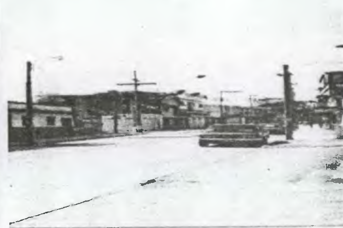
En la intersección de la 1ra. Calle "A" y la 13 Avenida existe una fuerte contaminación de postes y cables.
