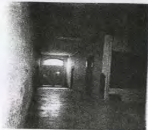
Foto No. 21 Este es uno de los ingresos de la Casa por la 13 avenida, en su interior existe un gran corredor el cual sirve de acceso a las áreas de servicio, especialmente abastece la despensa.
