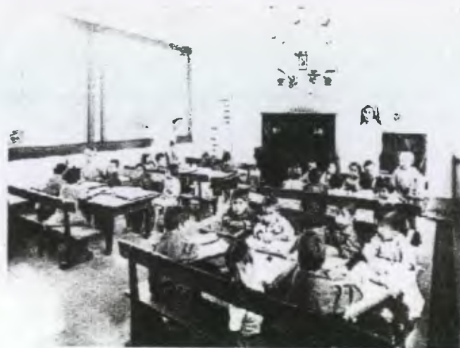
Los niños en sus horas de clases, se puede notar, los grandes ventanales, los cuales proporcionan buena iluminación y ventilación.
