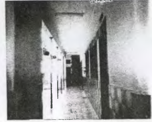
Foto No.65 Este es el corredor de las aulas el cual tiene desprendimiento en los acabados de la pared y zócalos, al final esta un aula a la cual se le agregó Rejas a la ventana
