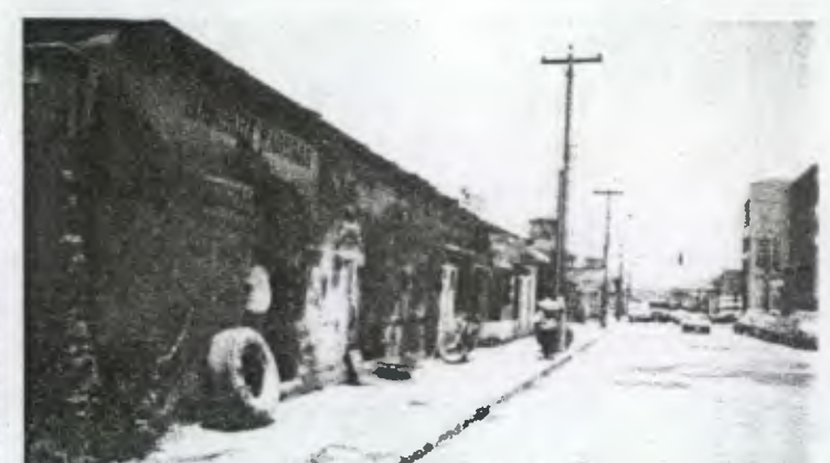
Foto No.10 En la 14 avenida existen comercios formales e informales como se aprecia en esta foto lo cual provoca mala imagen al sector, casas de adobe en mal estado, a esto se agrega la contaminación de rótulos y suciedad.
