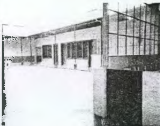
Foto No.5 Esta es la alteración que se dio en el corredor, un levantado de ladrillo y vidrio el cual rompió totalmente con el esquema original de la Casa.
