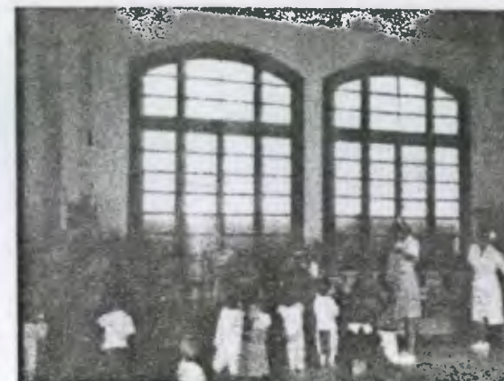
Foto No.3 Esta es una de las aulas, las cuales cuentan con grandes ventanales, las cuales se encuentran un poco deteriorados en sus sobremarcos por la polilla.
