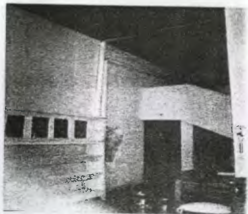
Foto No. 25 Este ambiente era un patio, pero tuvo que ser techado para convertirlo en una área de servicio ya que el espacio no era suficiente para colocar los gabinetes en la cocina.
