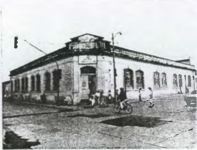
Foto No.1 Esta es la Casa del Niño No.2 que esta ubicada en la 13 avenida y 1ra. Calle de zona 1. Se observa la contaminación de postes y cableados.
