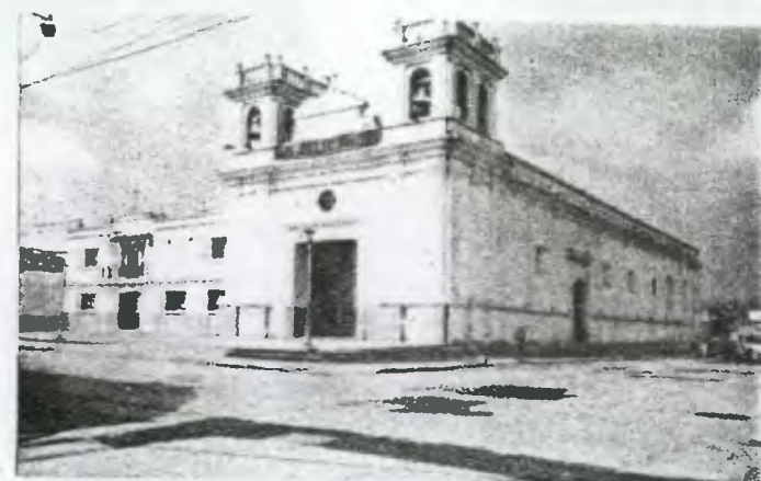
Foto No. 20 Frente a la Casa del Niño se encuentra la famosa Iglesia de Candelaria, la cual data del año 1810, sufrió severos daños con los terremotos pero ha sido restaurada. En las afueras de este templo se mantiene sucio debido a las ventas callejeras.
