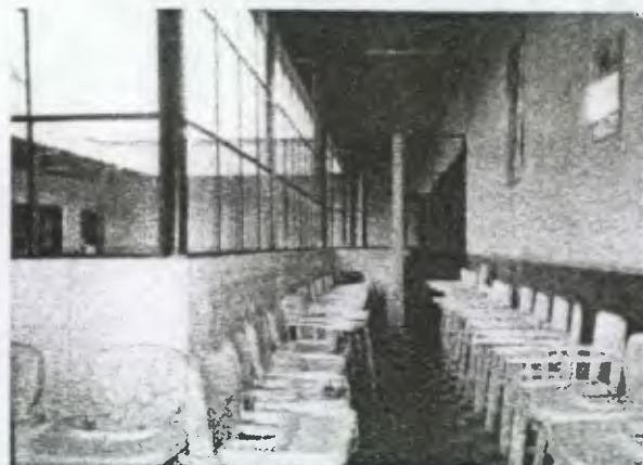
Foto No. 20 El comedor de bebés fue colocado en una parte del corredor por la necesidad de no tener más espacio se levanto un muro de ladrillo y vidrio cerrando así una cuarta parte del corredor alrededor del patio.
