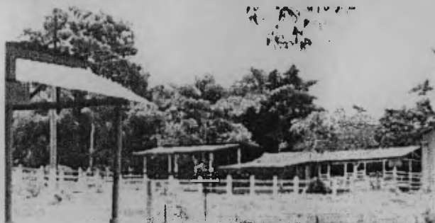
Fotografía 60. FACHADA SUR, ESTADO ACTUAL
