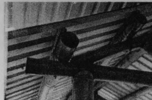
FOTOGRAFIA 5. DETALLE DE SUJECIÓN DE LÁMINA
