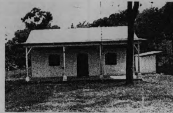
Fotografía 161. FACHADA NORTE AULA "A"
