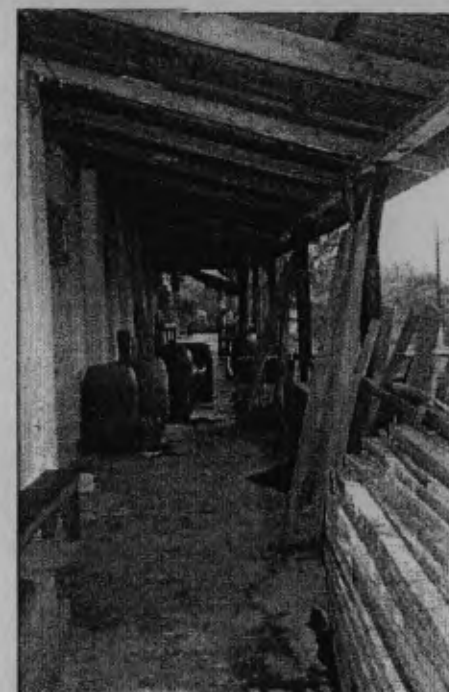
Fotografía 49. Vista corredor (O al E)
