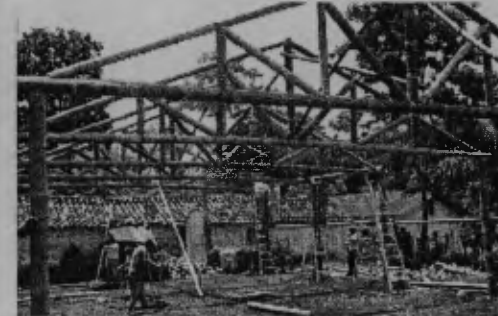
Fotografía 136. TIJERAS DE BAMBU TIPO HOWE
