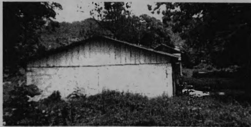
Fotografía 166. VISTA OESTE AULA "C"
