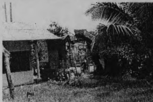
Fotografía 156. VISTA DEL B + S.S. DE SERVICIO
