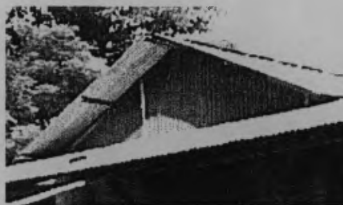
Fotografía 51. COLOCACION DE LAMINA EN MOJINETE
