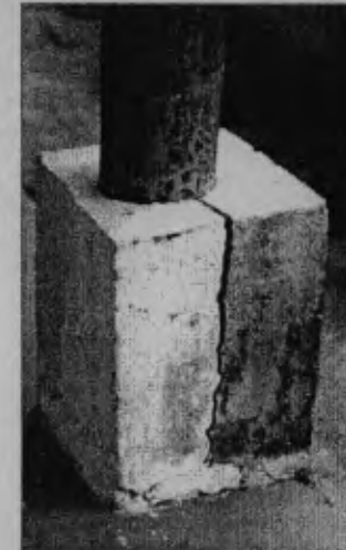
Fotografía 143. BASE DE COLUMNA
