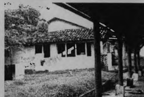
Fotografía 148. VISTA SUR COCINA Y COMEDOR
