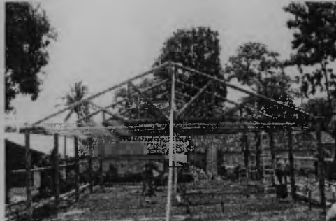
Fotografía 136. TIJERAS DE BAMBU TIPO HOWE
