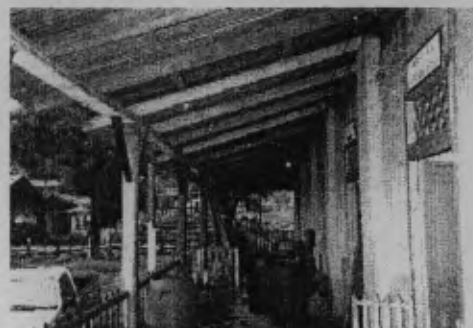
Fotografía 48. Vista corredor (E al O)
