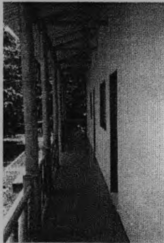
FOTOGRAFIA 8. CORREDOR ESTE CASA HABITACIONAL
