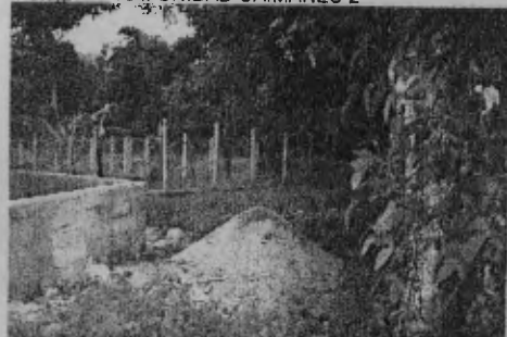
Fotografía 105. VISTA TANQUE CAPTACION DE AGUA
