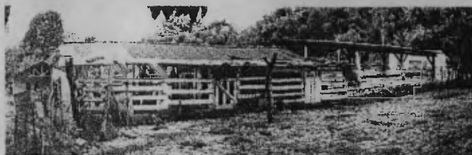
Fotografía 59. FACHADA NORTE, ESTADO ACTUAL
