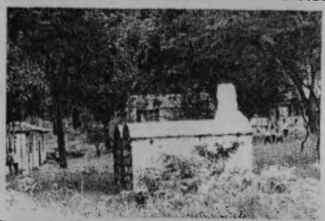
Fotografía 172. VISTA SURESTE ANTIGUA CARCEL
