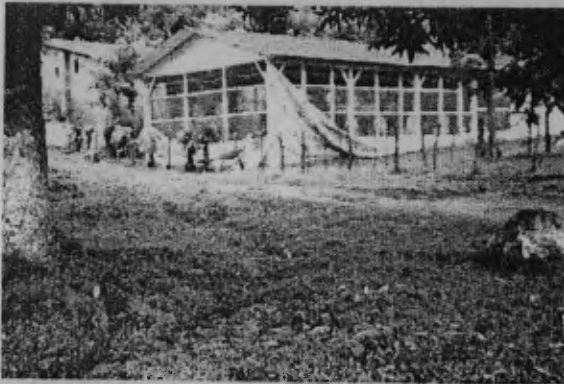
Fotografía 96. VISTA AUXILIAR SURESTE
