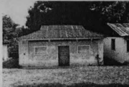
Fotografía 162. FACHADA NORTE AULA "B"
