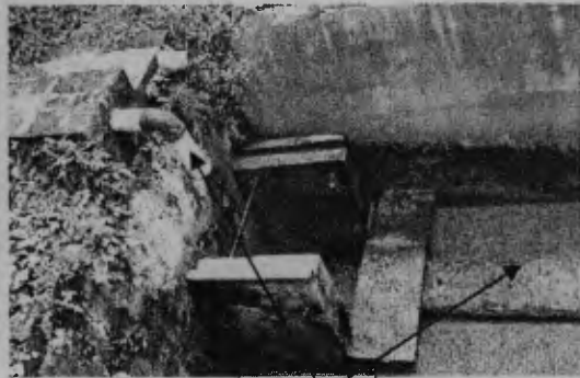
Fotografía 10 (Drenaje unidad porcinos)
