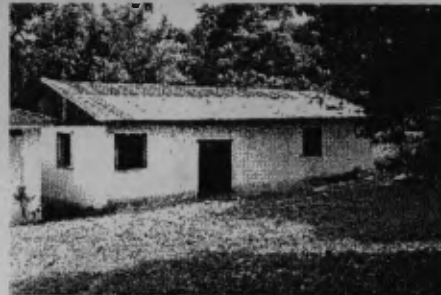
Fotografía 163. FACHADA NORTE AULA "C"
