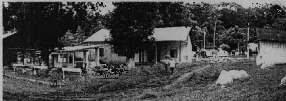
Fotografía 134. VISTA NORESTE ALBERGUE PROFESORES, AREA DE PILA Y SALON DE USOS MULTIPLES.
