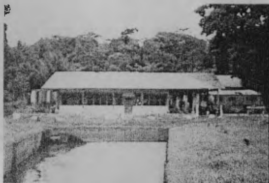
Fotografía 152. FACHADA ESTE DEL SUM.
