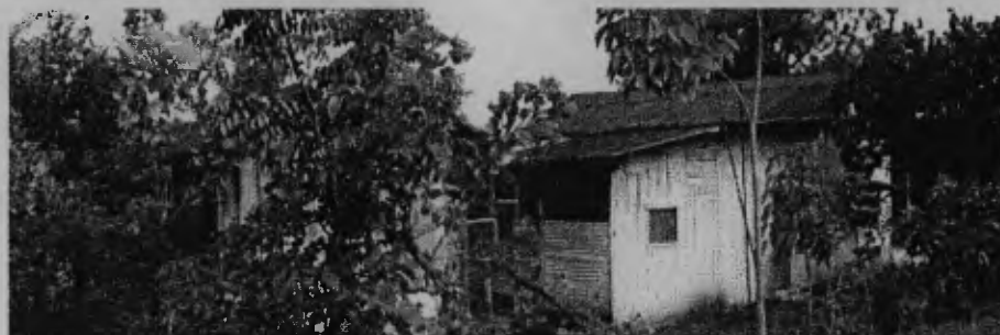
Fotografía 118. VISTA FACHADA OESTE
