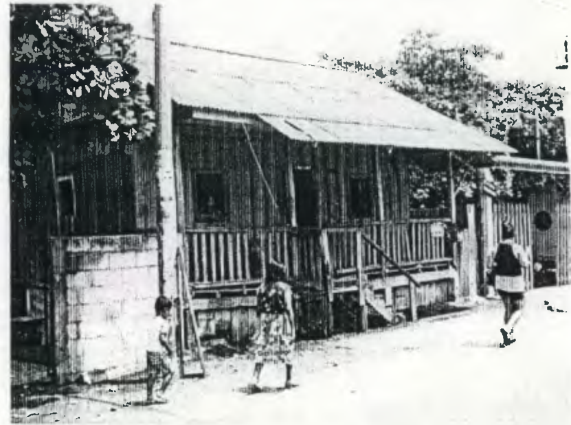
La madera y lámina predominan aún en la mayoría de estructuras, aunque se han agregado materiales como block y concreto.
