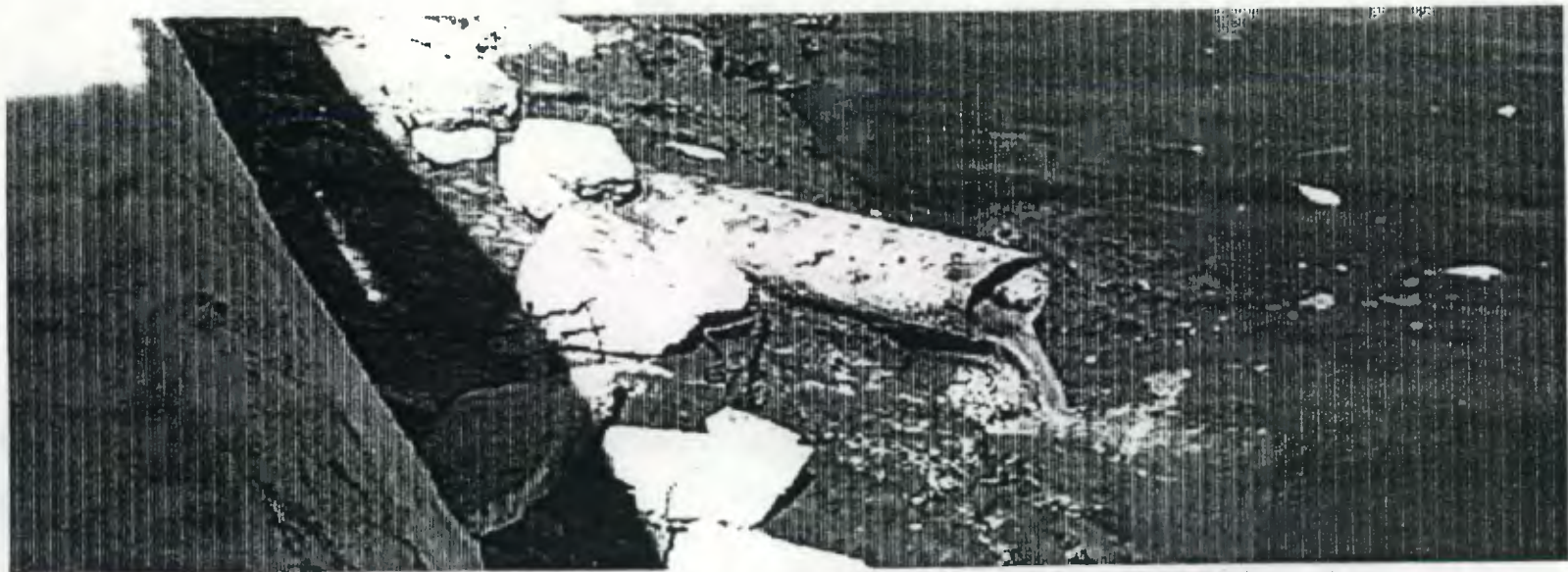
Los desagües van a desembocar al Canal de Chiquimulilla y los otros canales menores del área urbana
