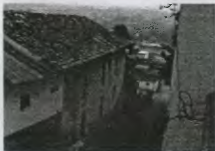
FOTOGRAFIA 6.2 Se observa en esta fachada la pendiente prolongada de la calle y el deterioro en los muros provocado por la humedad.
