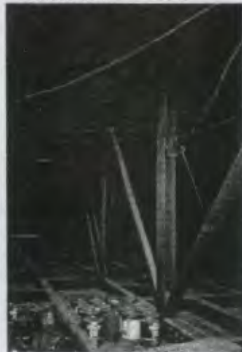
FOTOGRAFIA No. 6 Artesonado de madera de la cubierta.
