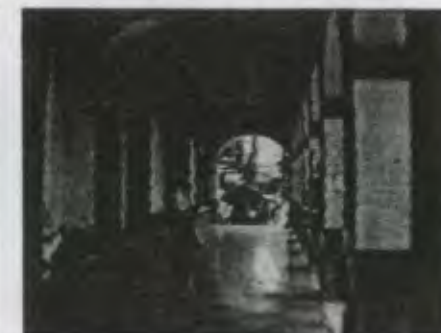
FOTOGRAFIA No. 8 Vista del corredor frontal del edificio.
