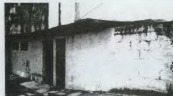
Ampliación posterior del edificio.
