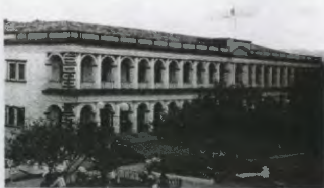
FOTOGRAFIA No. 3 Vista del Palacio de Gobernación Departamental
