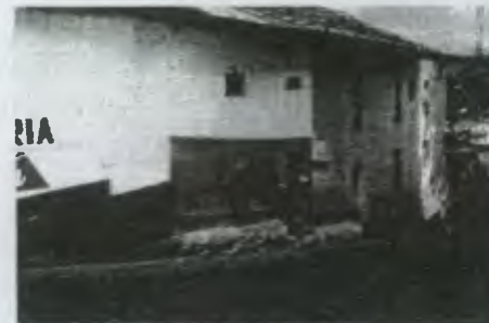
FOTOGRAFIA 6.1 Vista de la fachada a un costado del Palacio de Gobernación en la que predomina la vivienda.
