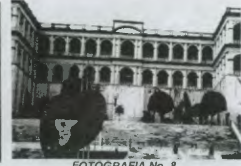
FOTOGRAFIA No. 8 Vista de la parte posterior del edificio.
