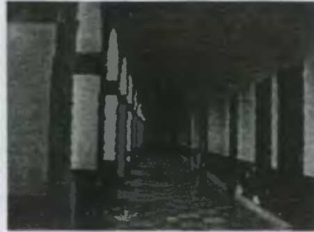
FOTOGRAFIA No. 1 Vista del corredor sur.
