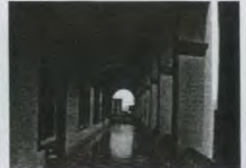
FOTOGRAFIA No. 2 Vista del corredor norte.
