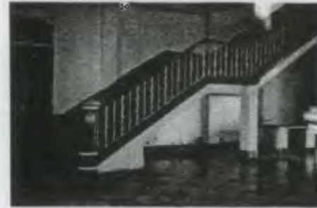
FOTOGRAFIA No. 1 Escaleras que conducen del primer al segundo nivel.
