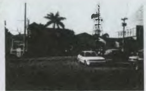
FOTOGRAFIA 2.2 Vista de las instalaciones de TELGUA.
