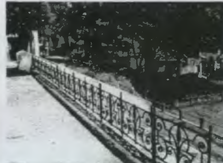
FOTOGRAFIA No. 6 Baranda de hierro en la parte posterior.
