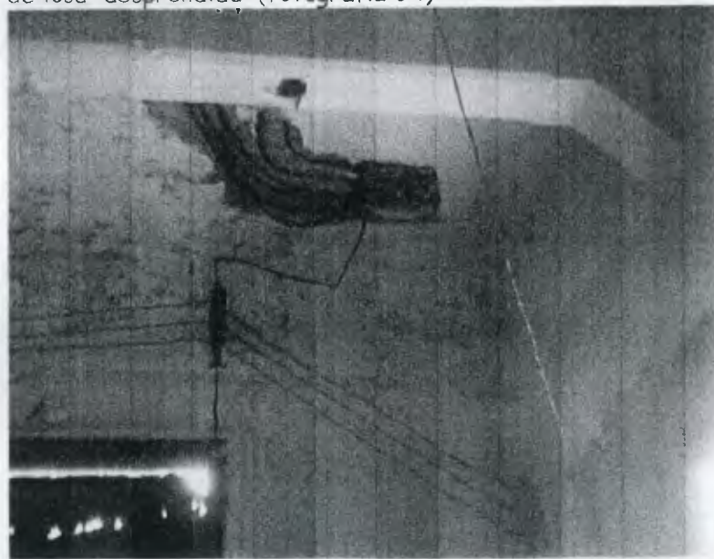
Ductos de Instalaciones Eléctricas expuestas y corroídas, porción de losa desprendida (fotografía 34)
