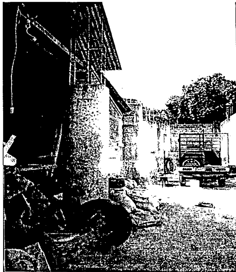
Según se puede observar, no existe ningún tipo de regulación para la construcción, ya que construcciones como estas se encuentran en todo el casco urbano.
