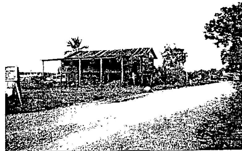
En el área cercana a Arrollo Petexbatún en el barrio El Pescador las casas se levantan hasta un metro cincuenta centímetros debido a lo cercano que se encuentran del área de inundación.
