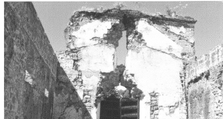
Fotografía No.12 Vista Interior muro de Fachada
