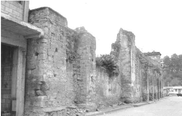
Fotografía No.11 Muro lateral exterior.
