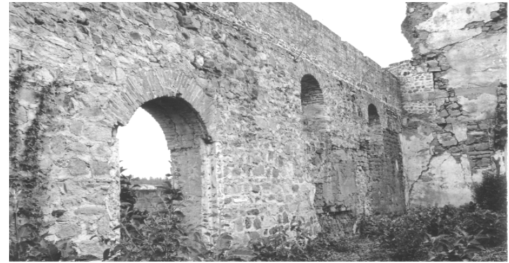
Muro lateral Sur-este
