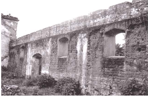
Muro lateral Nor-este vista interior
