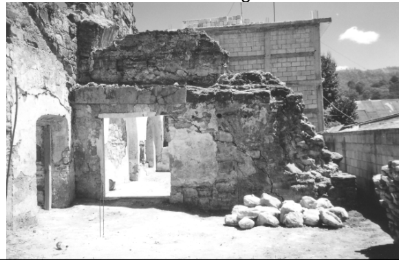
Fotografía No. 6 Ingreso a Sacristía
