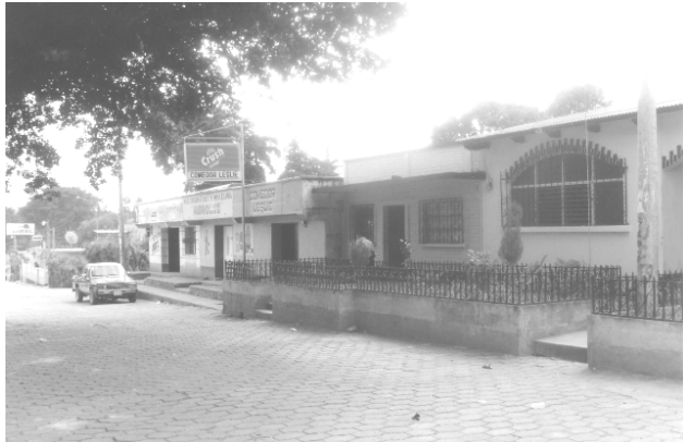
En esta fotografía, se muestra la contaminación por rótulos en los comercios que se encuentran ubicados a la par de la Municipalidad.
