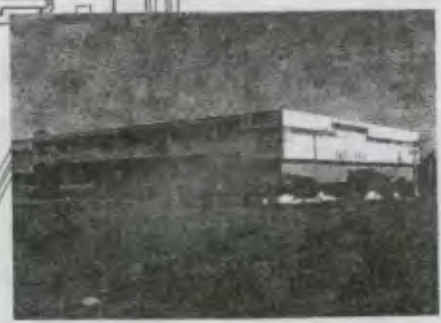
Vista exterior de edificio S-11
