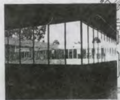
Pasillo interior de edificio S-2
