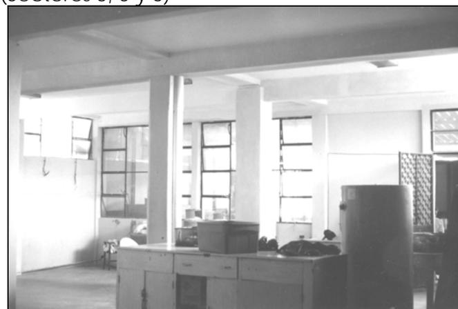
El área de cocina en el sector 3 se ha modificado, con el reforzamiento de su estructura con nuevas vigas y columnas.
