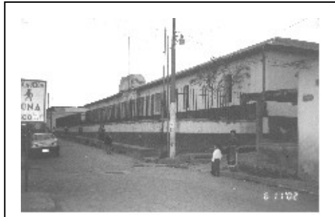
Toma N° 4 Fachada Principal de la Escuela Miguel García Granados
