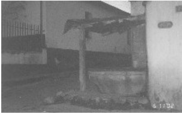
FOTOGRAFÍA N° 8 VISTA DE LA PILETA (FRONTAL) UBICADA EN LA ELEVACIÓN ESTE
