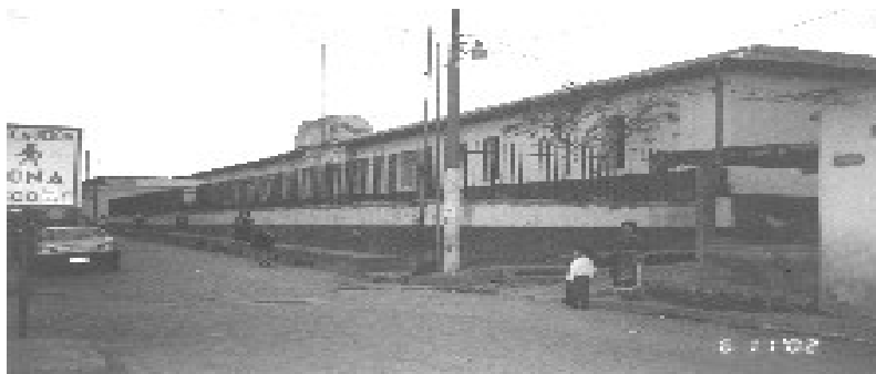
FOTOGRAFÍA N° 16 DE ELEVACIÓN SUR
