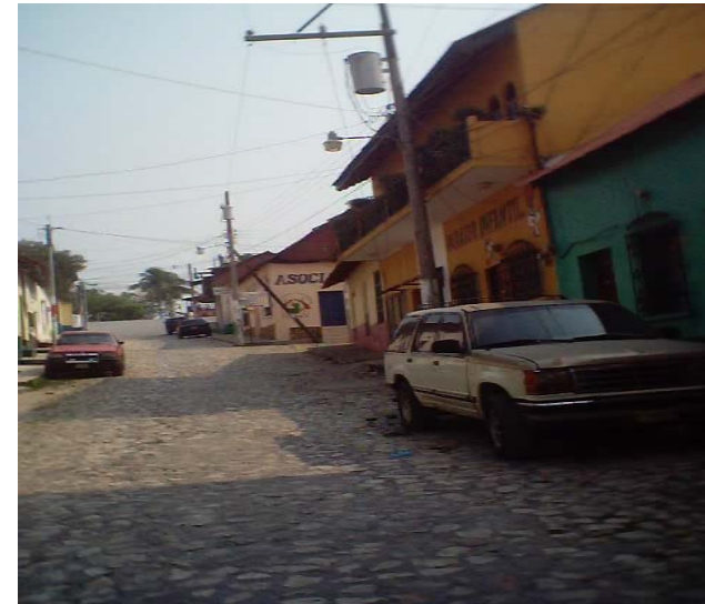
Foto 65 Estado actual de la Avenida Barrios
