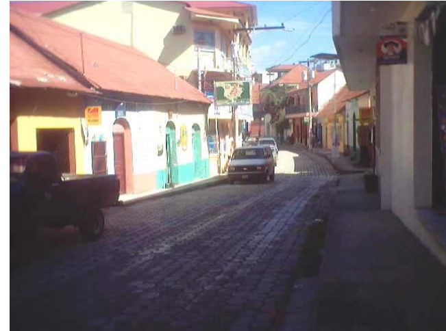
Foto 67 Estado actual de la Calle Centro América
