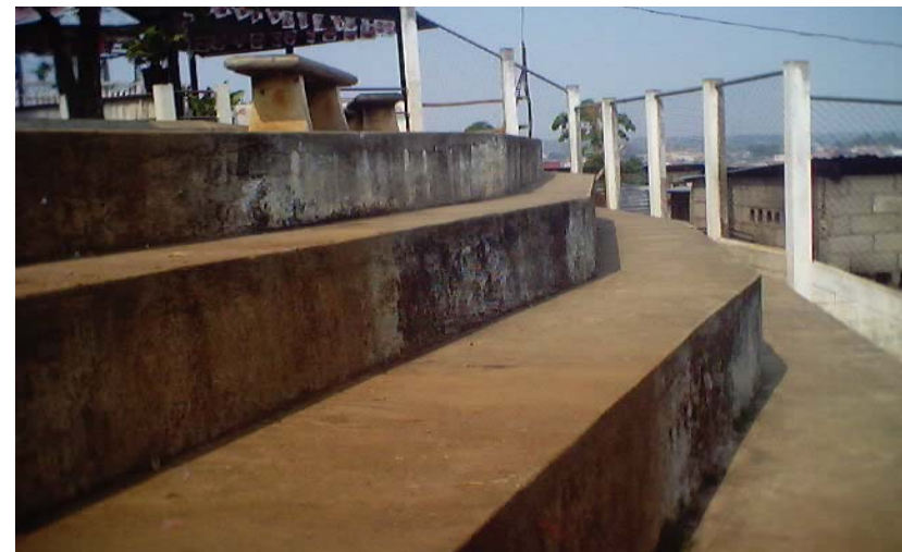
Foto 38 Estado actual del Mirador Chi Kin
