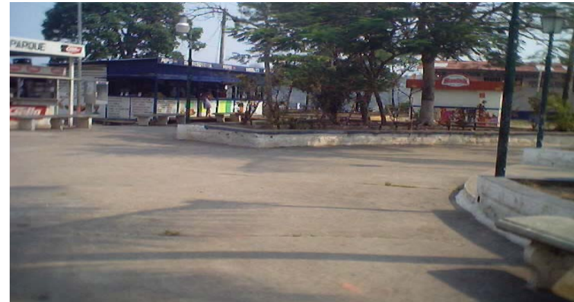
Foto 37 Estado actual del Mirador Chi Kin
