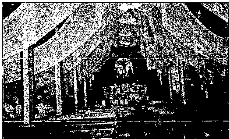
F 40 Se observa las tres naves interiores, la cubierta sostenida por pilares de madera con base de piedra, al fondo el altar y retablo con el Cristo Negro de Esquipulas.
