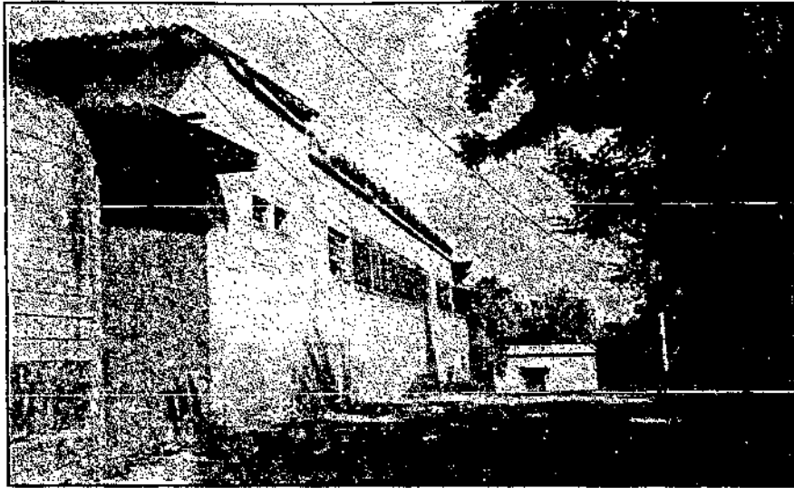
F 26 Se observa el muro sur de la escuela, presenta material sin acabado exterior y ventanas con balcones y malla para la protección, los materiales de las ventanas no permiten un adecuado acceso de luz y ventilación.
