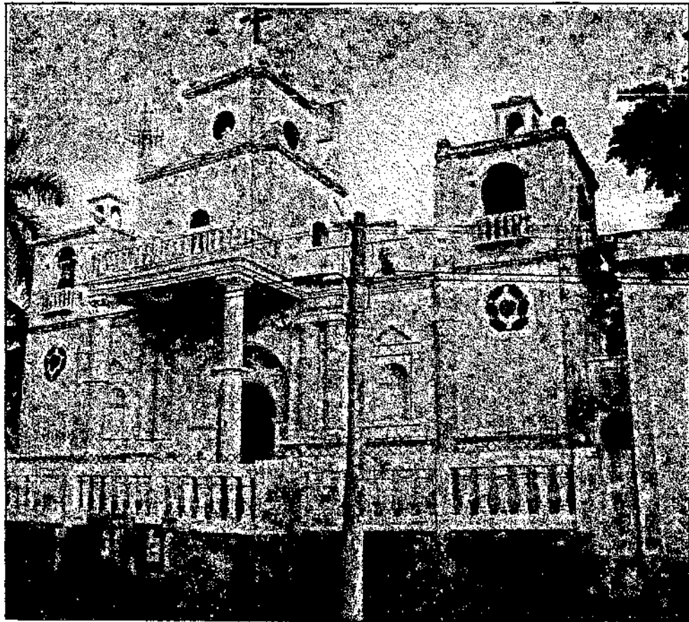
F 17 Fachada principal del Templo parroquial, se observa el ingreso principal así como las modificaciones en los campanarios y la parte central sobre el ingreso.
