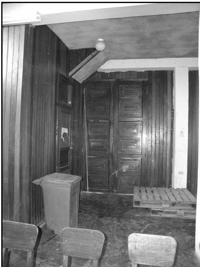
VISTA DEL FORRO EN VESTIBULO DE INGRESO DEL TEATRO MUNICIPAL
