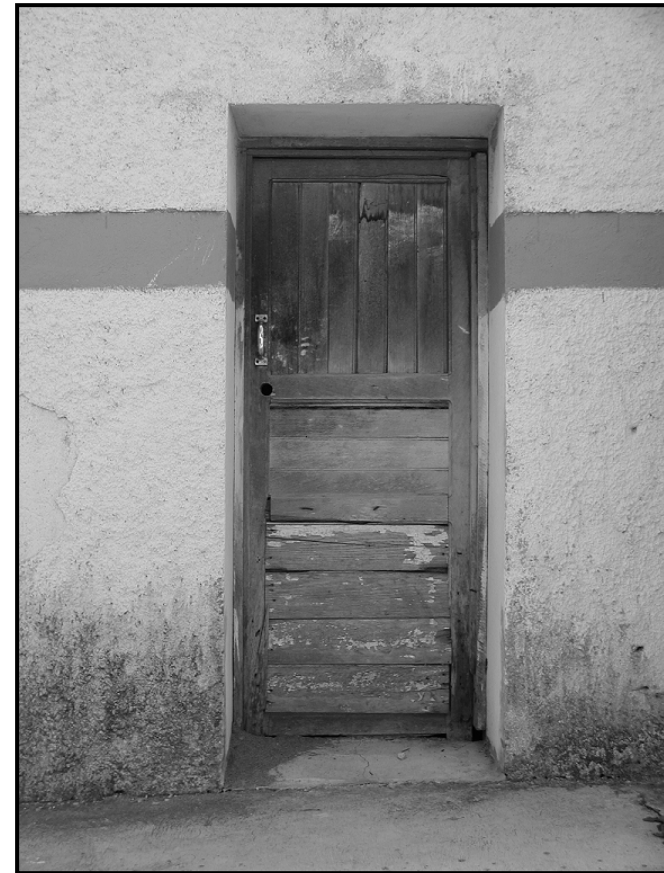
VISTA PUERTA DE INGRESO SECUNDARIO HACIA EL TEATRO
