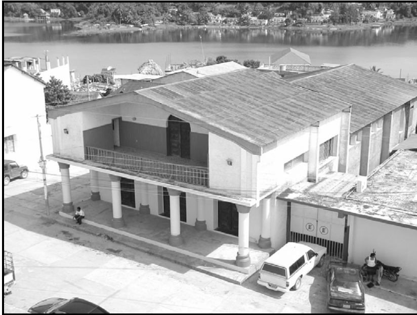
VISTA FRONTAL DEL ZOCALO Y COLUMNAS DEL TEATRO MUNICIPAL
