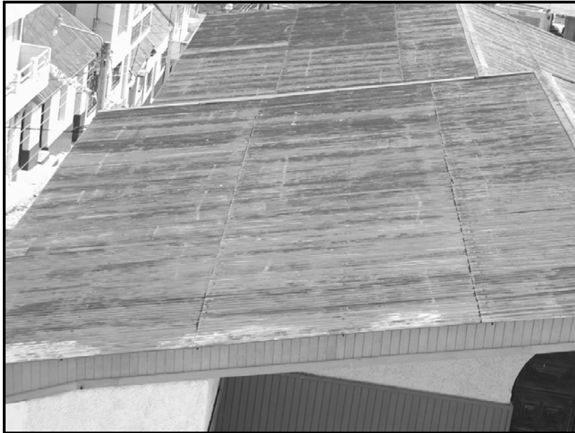
VISTA AEREA DE LA CUBIERTA
