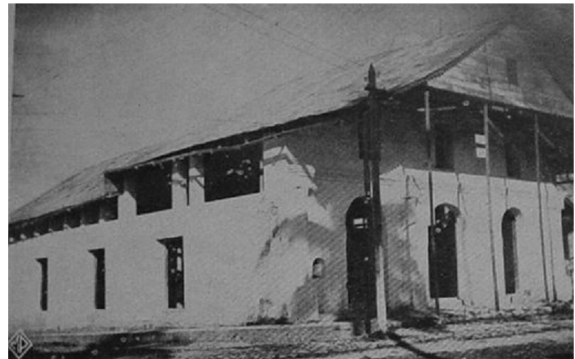
FOTOGRAFÍA DEL TEATRO MUNICIPAL DURANTE SU CONSTRUCCIÓN EN 1939
