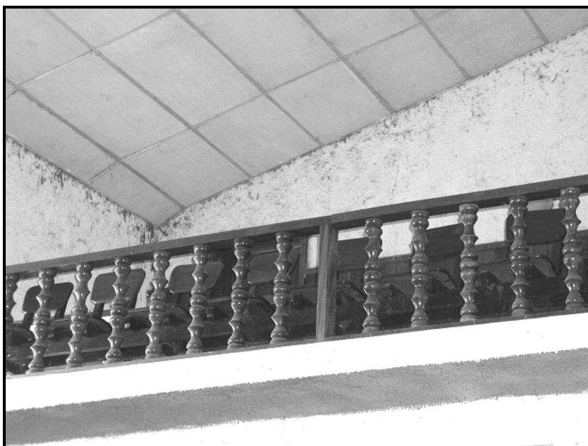
VISTA PARCIAL DE LA BARANDA DEL MEZANINE DEL TEATRO MUNICIPAL
