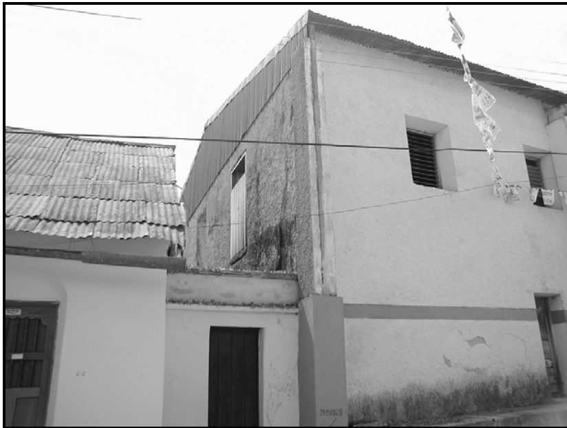
VISTA PARCIAL DE LAS ELEVACIONES LATERAL IZQUIERDA Y POSTERIOR
