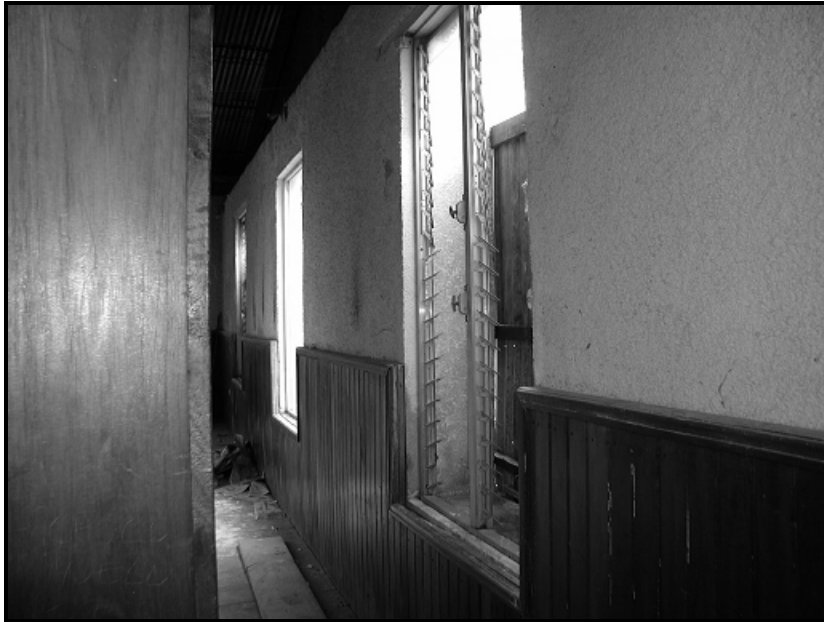
VISTA INTERIOR DE LA ELEVACIÓN POSTERIOR
