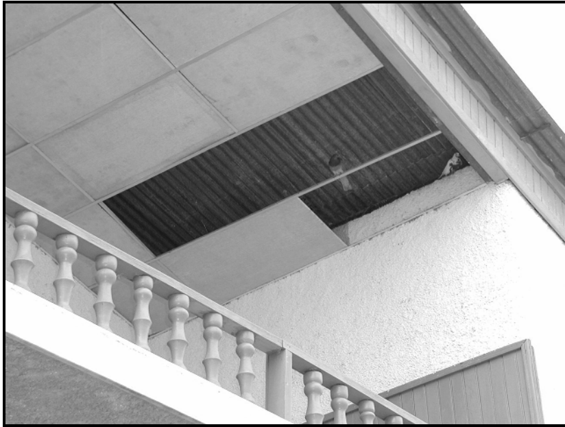
VISTA DEL CIELO SUSPENDIDO EN EL BALCON DEL TEATRO MUNICIPAL
