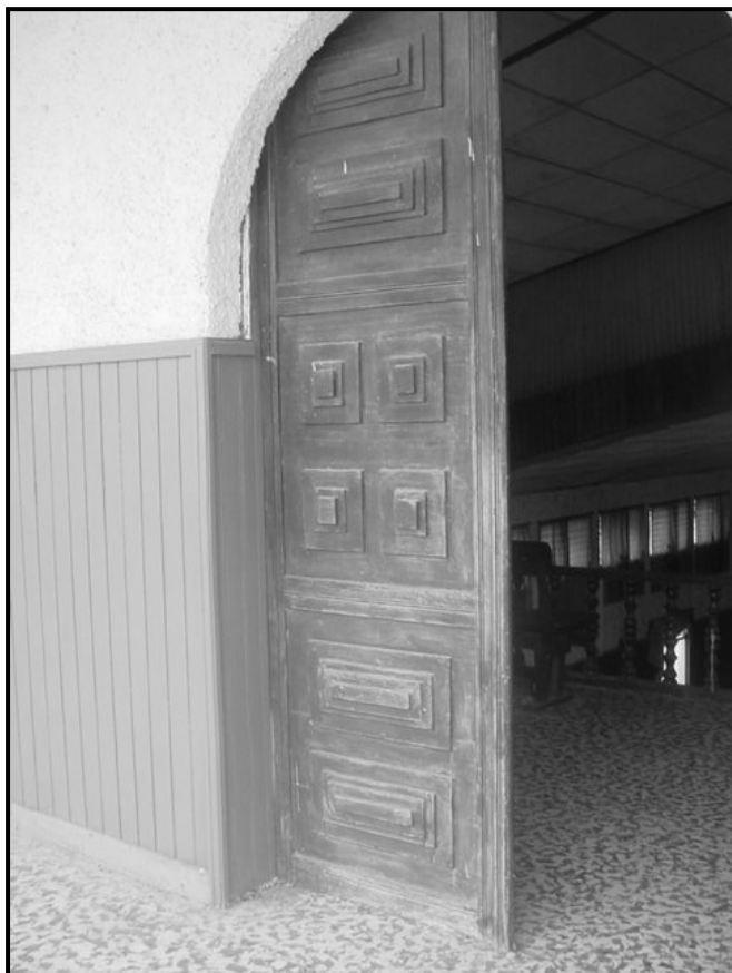
VISTA PUERTA DEL MEZANNINE HACIA EL BALCON
