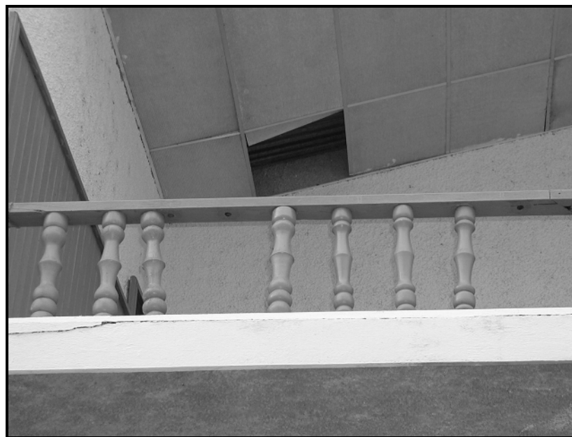
VISTA DE LA BARANDA DEL BALCÓN DEL TEATRO MUNICIPAL
