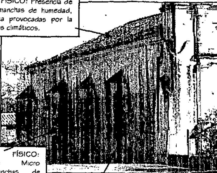
Fotografía No. 21 Alteraciones y deterioros de Fachada Lateral Norte.
