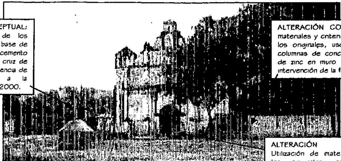
**ALTERACIÓN CONCEPTUAL:** Utilización de materiales y ctenos constructivos distintos a los originales, uso de paredes de block y columnas de concreto y portones de lámina de zinc en muro perimetral, producto de la intervención de la fachada en 1982.
