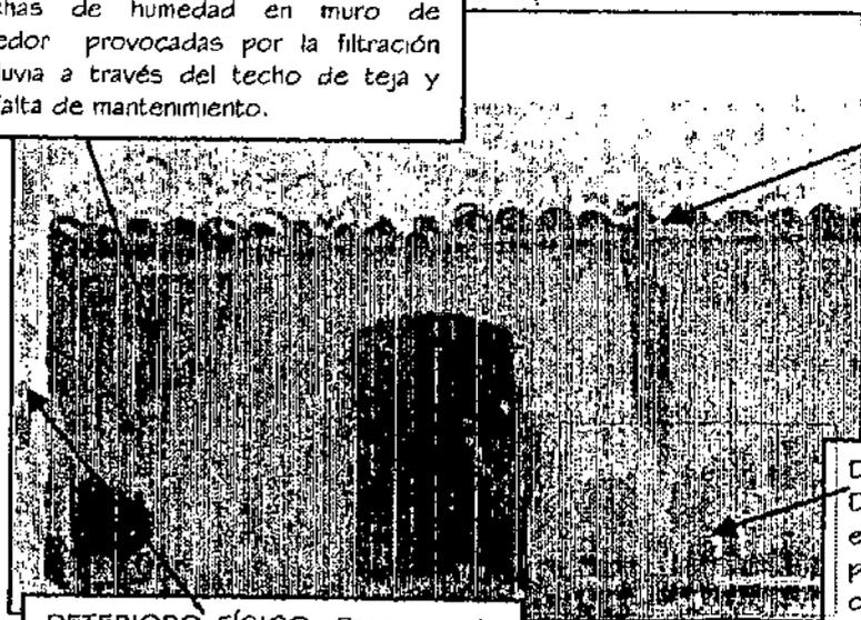
**DETERIORO FÍSICO:** Presencia de Micro organismos, manchas de humedad, provocadas factores climáticos en contra fuerte del muro lateral.
