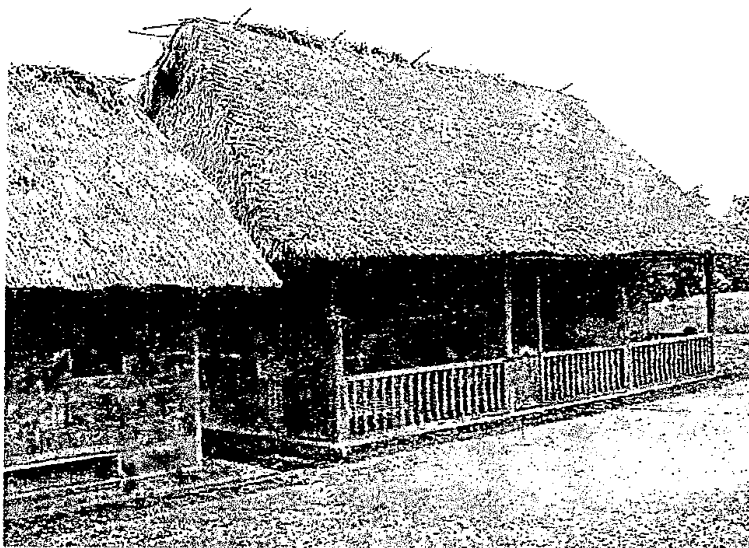
FOTO 26 Construcción típica del lugar
