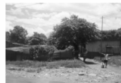
Fotografía # 32. En la parte posterior del edificio sobre la 4ª. Calle observamos viviendas y una pequeña calle.
