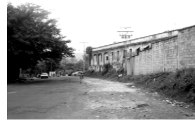
Fotografía #3 Fachada Sur Sobre 3ª. Calle.
