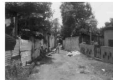
Fotografía # 18. Lado posterior de la escuela, se puede observar viviendas, informales adosadas al muro del edificio (lado derecho)
