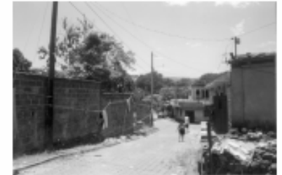
Fotografía # 15. Vista hacia colonia El Pito, Lado izquierdo Muro de block de la escuela al Lado Derecho Viviendas
