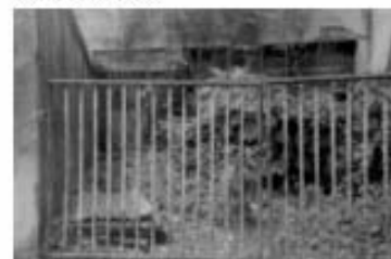
Fotografía #61. En la parte posterior del edificio observamos crecimiento de vegetación, y una verja deteriorada por el oxido.
