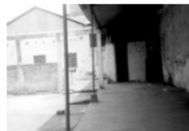
Fotografía #69. Al fondo se observa el área de lavandería, sin cubierta.
