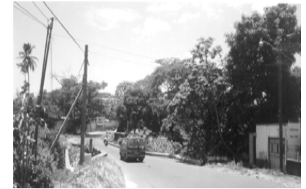
Fotografía #4 Sobre 3ª. Calle vista sobre puente el Pito.
