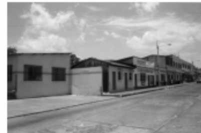
Fotografía # 24. Sobre la 3ª. Calle "A" se observa una vivienda tradicional de la costa sur, las demás son viviendas de dos niveles.
