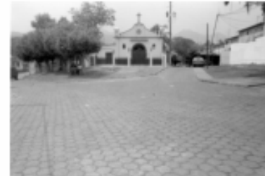
Fotografía # 14. Observando sobre la 1ª. Av. Al lado de Plaza Palmeros. Se encuentra el ingreso a la Col. San Pedro (a la derecha), Col. El Pito (a la izquierda) y La iglesia de San Pedro al centro.
