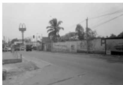
Fotografía # 38. Vista general hacia
