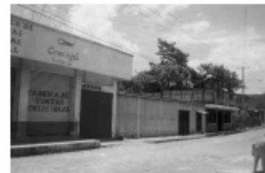
Fotografía # 26. Sobre la 4ª. Calle se observa techos baldíos y viviendas de mader.
