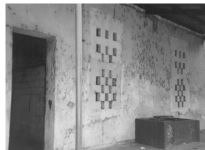
Fotografía #8 vanos de ventanas sellados
