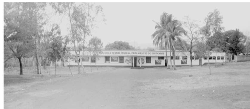
Fotografía #7 Fachada Frontal sobre el este, al frente el área de parqueo y área de juegos
