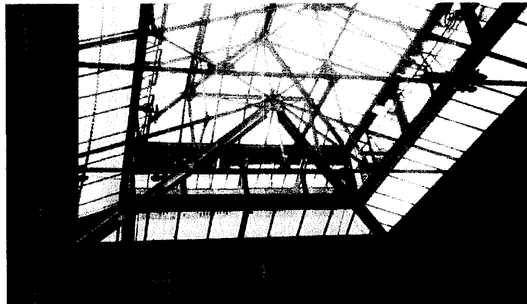
Ver el detalle del sistema de cubierta de una de las naves de bodegas, cuyo objetivo fundamental es el adecuado tratamiento de iluminación al interior de la edificación.
