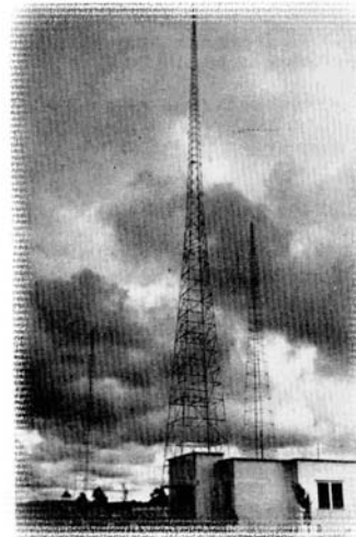
Fotografía No. 45 ANTIGUA PLANTA DE TRASMISORES Y TORRES EN CAMPO MARTE.
