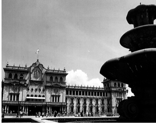
PALACIO NACIONAL: Edificio emblemático de su gobierno. Construcción 1939 - 1943
