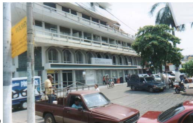
FOTO No. 10 Visual de Instituciones Bancarias ubicadas en el Edificio Morán, sobre la 5ta Avenida esquina de la 5ta calle de la zona 1.
