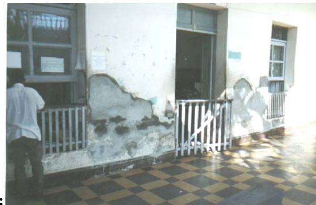
Fotografía No. 18: Daños en las paredes, son los que se producen con mayor frecuencia, junto al suelo, porque son las partes de la construcción que están más expuestas a recibir golpes de toda clase y frecuencia. Al fondo se observa otro entrepiso de madera, ubicado en el Departamento de Aguas y Drenajes.
