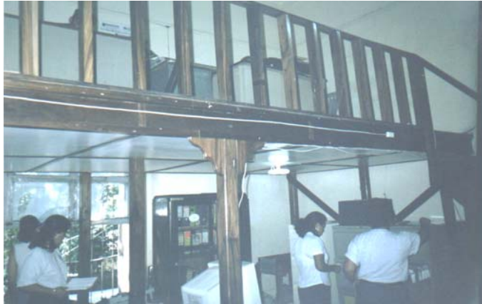
Fotografía No. 16: Entrepiso de madera, colocado en las oficinas de la Empresa Eléctrica, el cual es utilizado para ubicar las áreas de trabajo, espacio insuficiente y demasiado personal.
