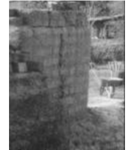
Fotografía 9: Construcción de adobe.
