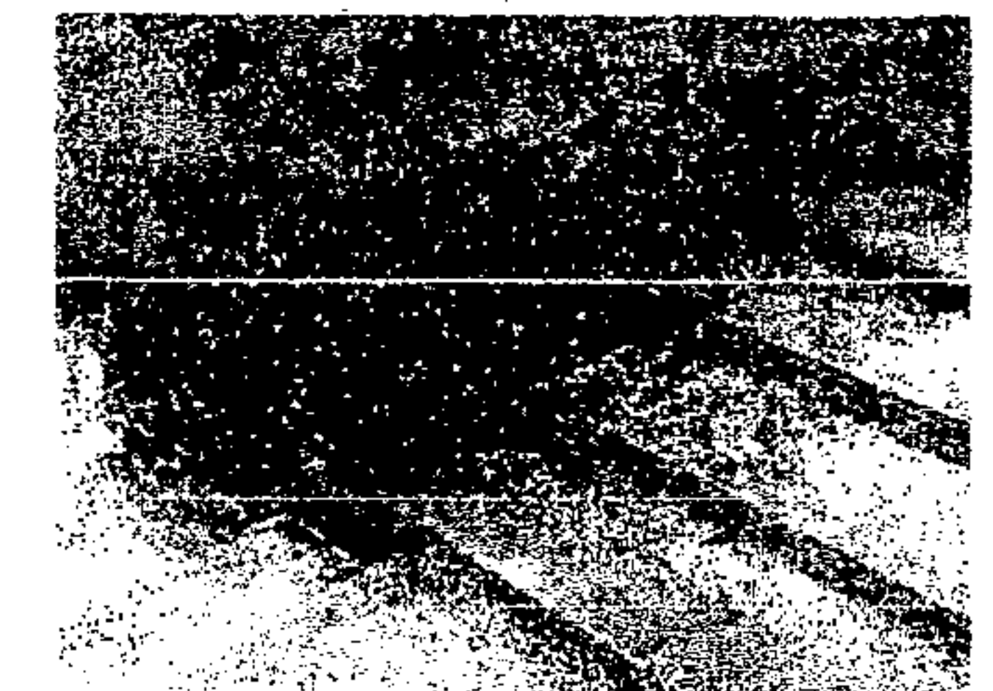
FOTO No. 44 Más de 25 % se necesita gradas.
