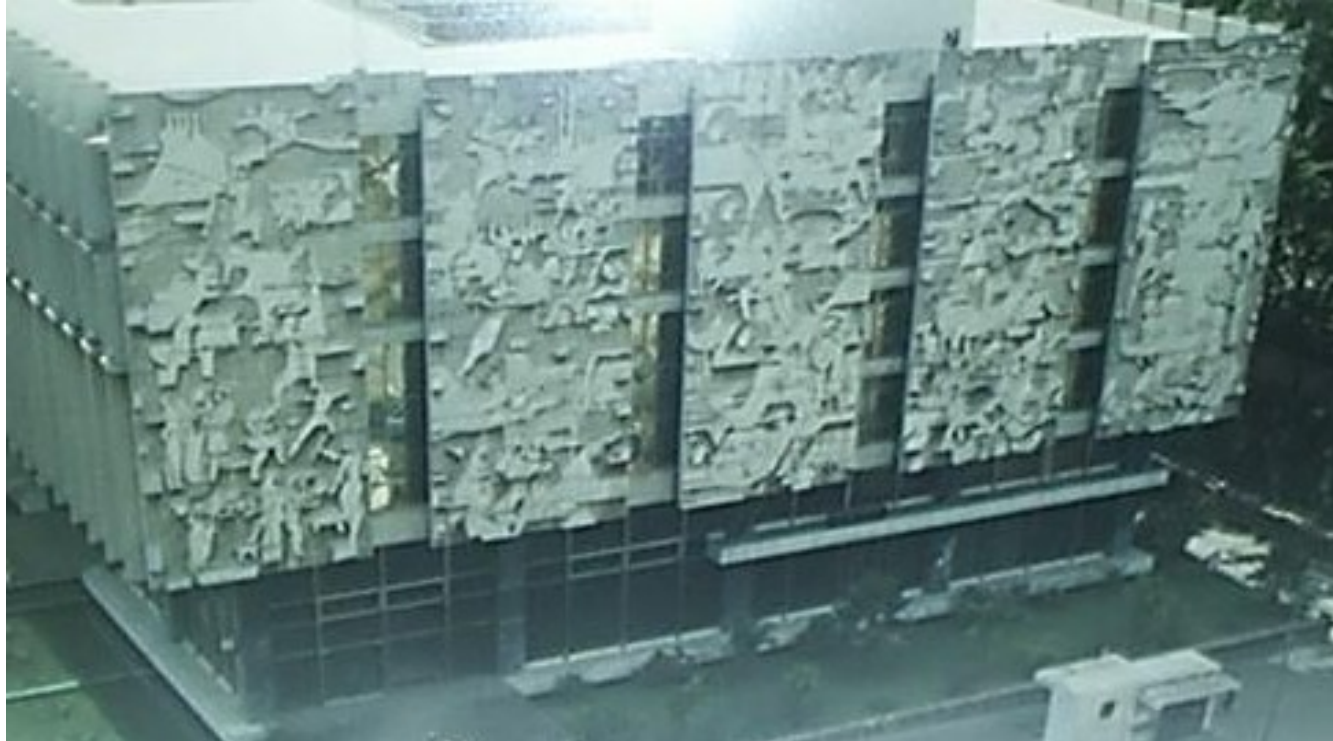
Vista general Fachada Poniente Crédito Hipotecario Nacional. Foto: Maestro Efraín Recinos.
