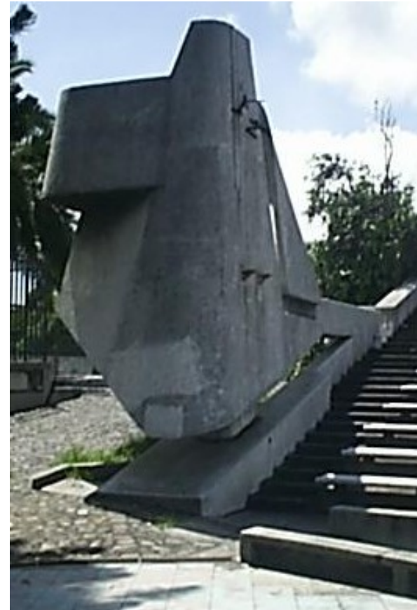
Detalle de Arquitectura en ingreso principal del Teatro al Aire Libre.
