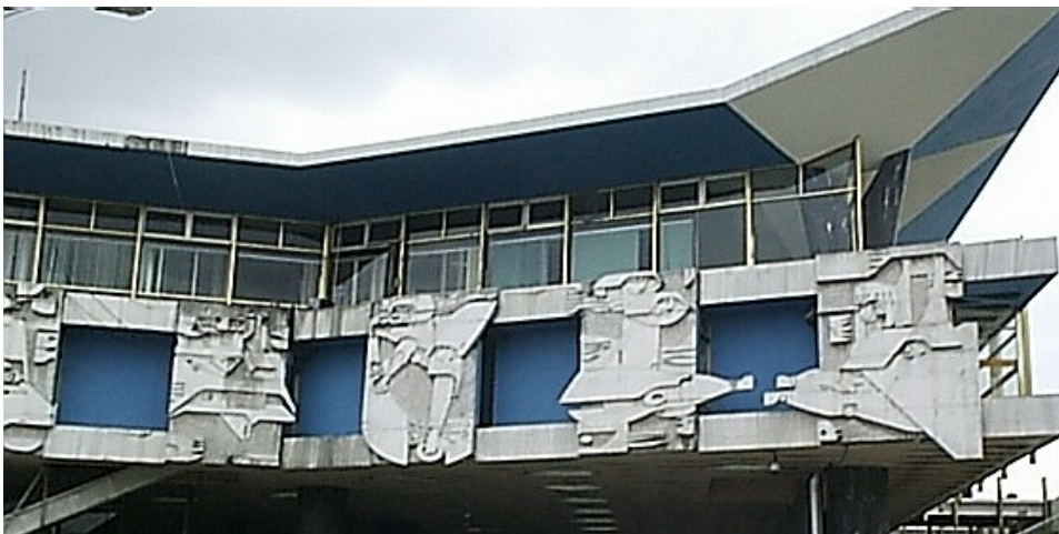
Fragmento de Visual General Murales Exteriores Terminal Aérea La Aurora. Lado Norte.
