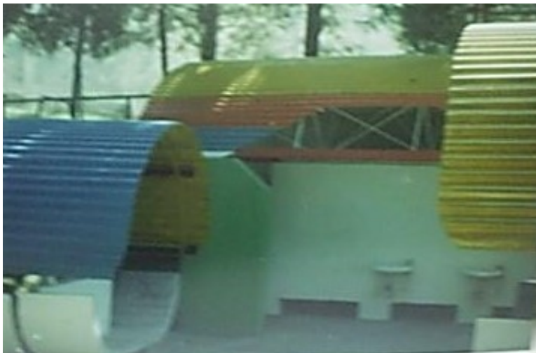
Detalle de Bancas para las Madres en el Área de sanitarios del Parque Infantil. Foto: Maestro Efraín Recinos.
