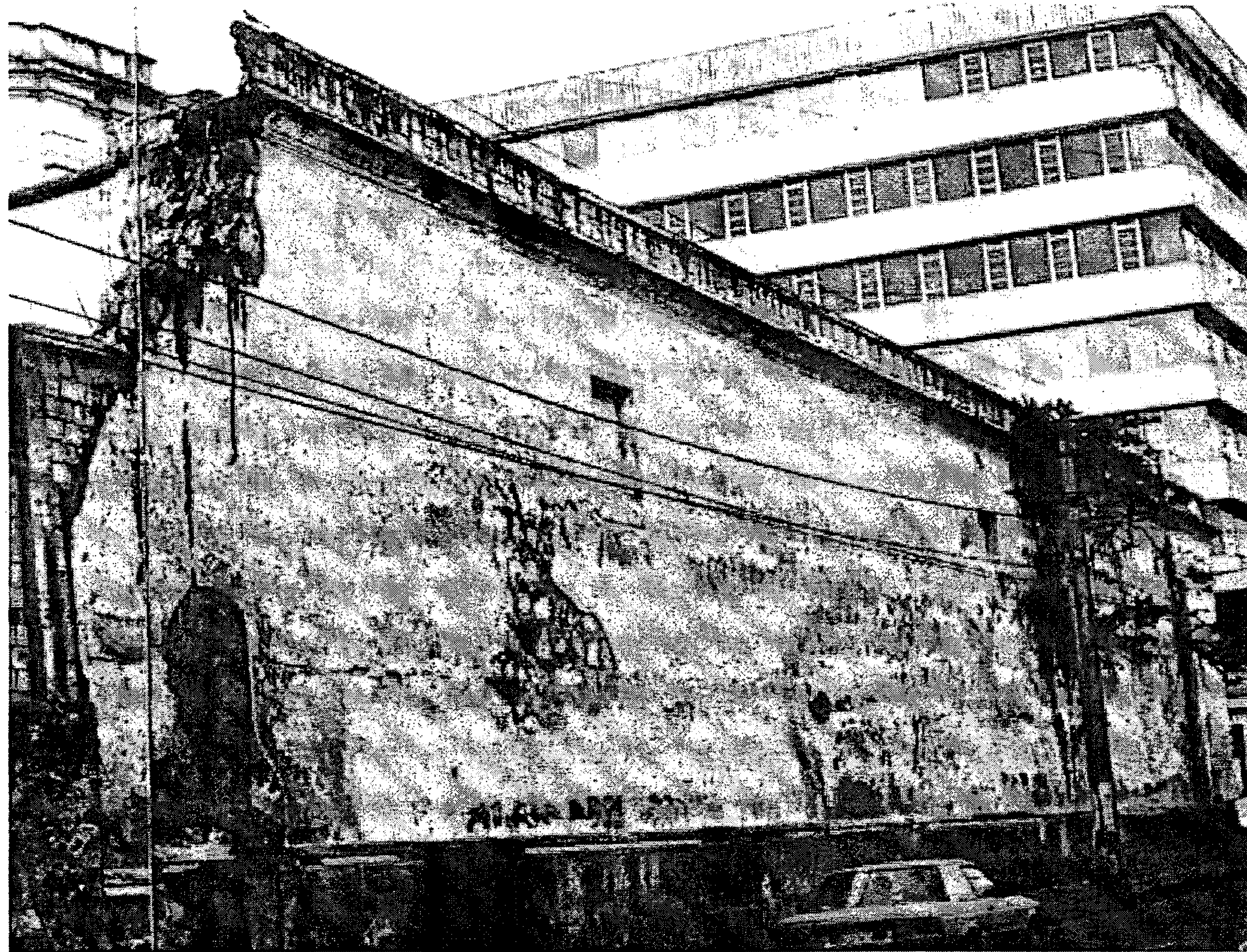
Fotografía No. 95: muros sobre 7ª avenida
