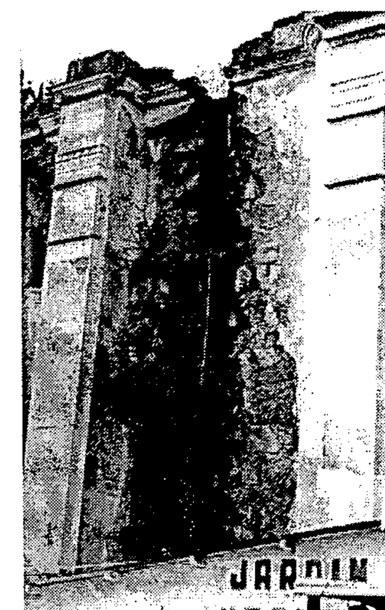
Fotografía No. 88: erosión del muro sur del ábside
