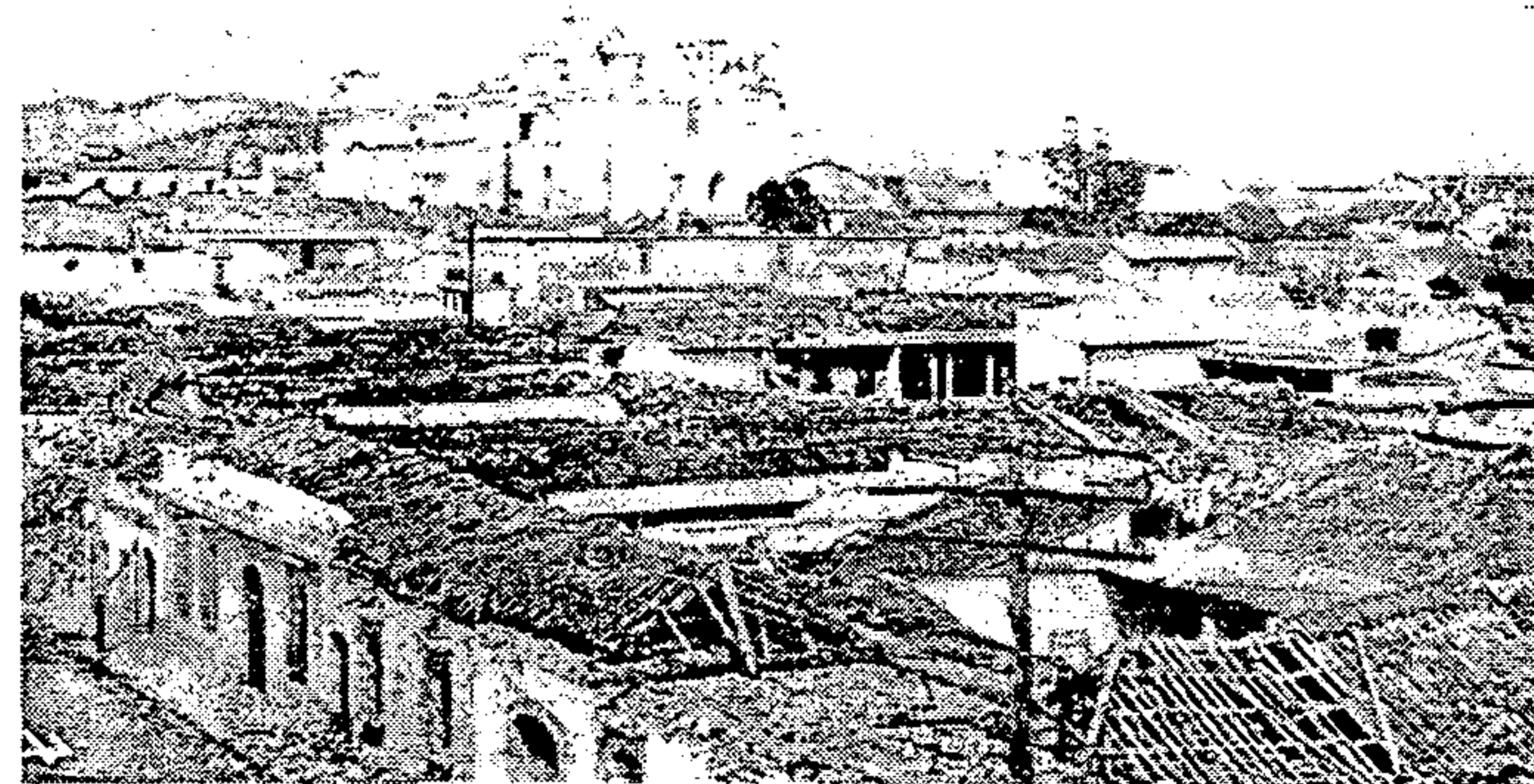
Fotografía No. 26: panorámica de los daños evidentes post-terremotos 1917-18, en el conjunto franciscano y alrededores 362
