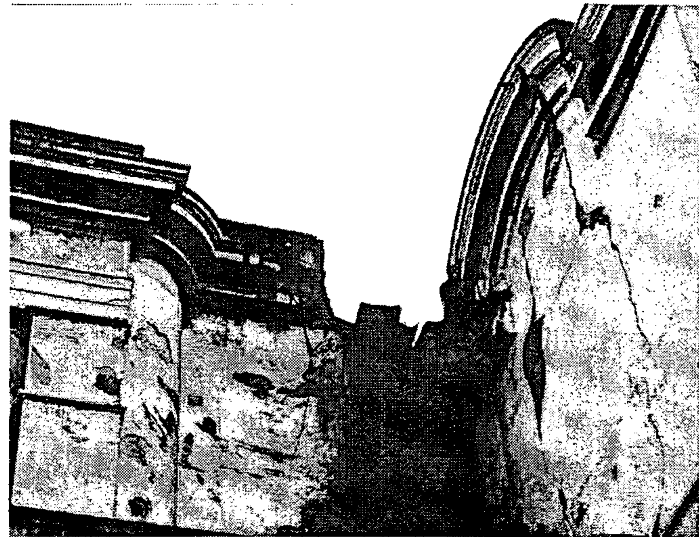
Fotografía No. 101: intersección del campanario y ábside norte Al lado de la intersección del campanario se manifiesta la grieta descrita en la fotografía No. 94; ésta también carece de conducción de agua pluvial, y asimismo manifiesta abundante macroflora
