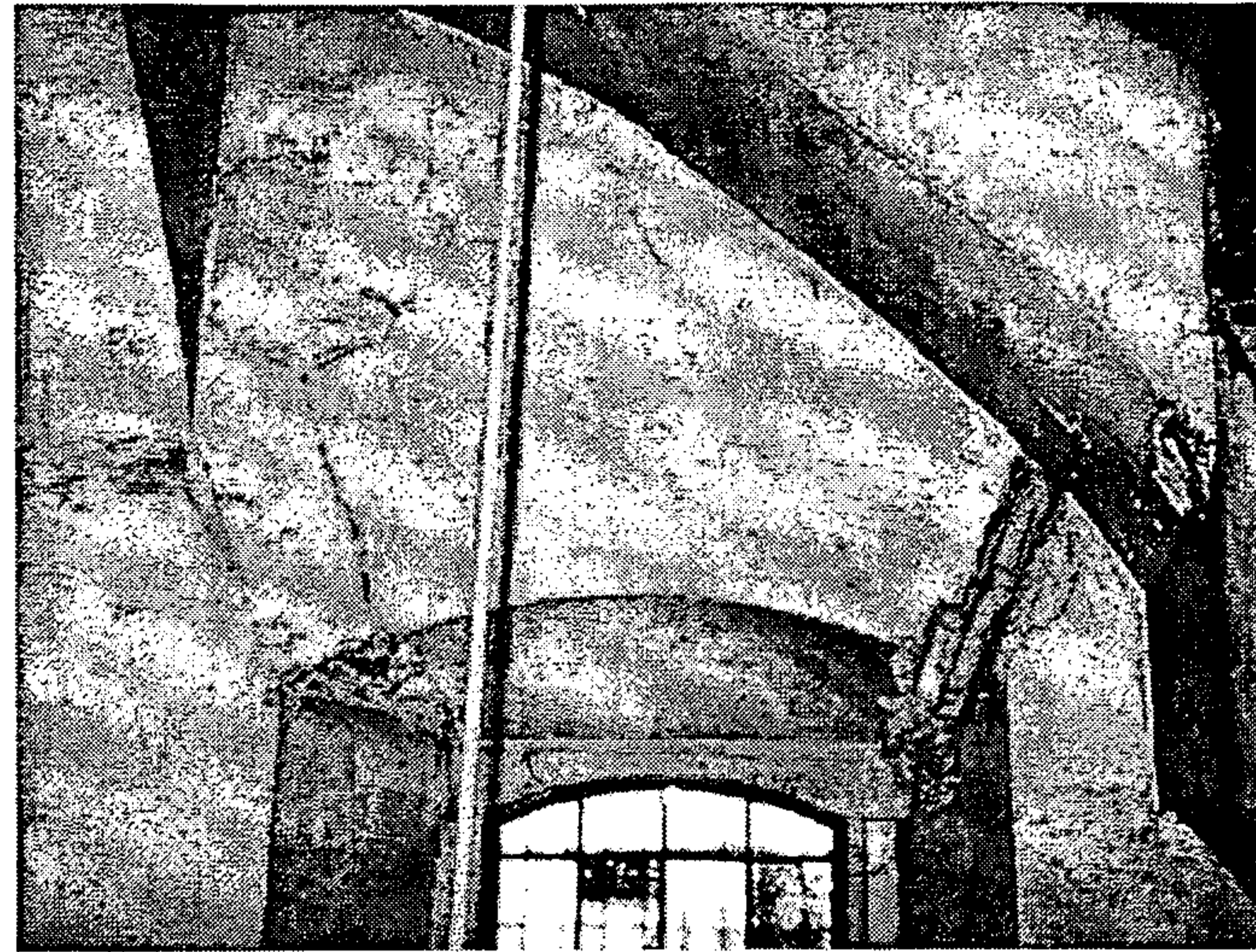
Fotografía No. 127: ventana
