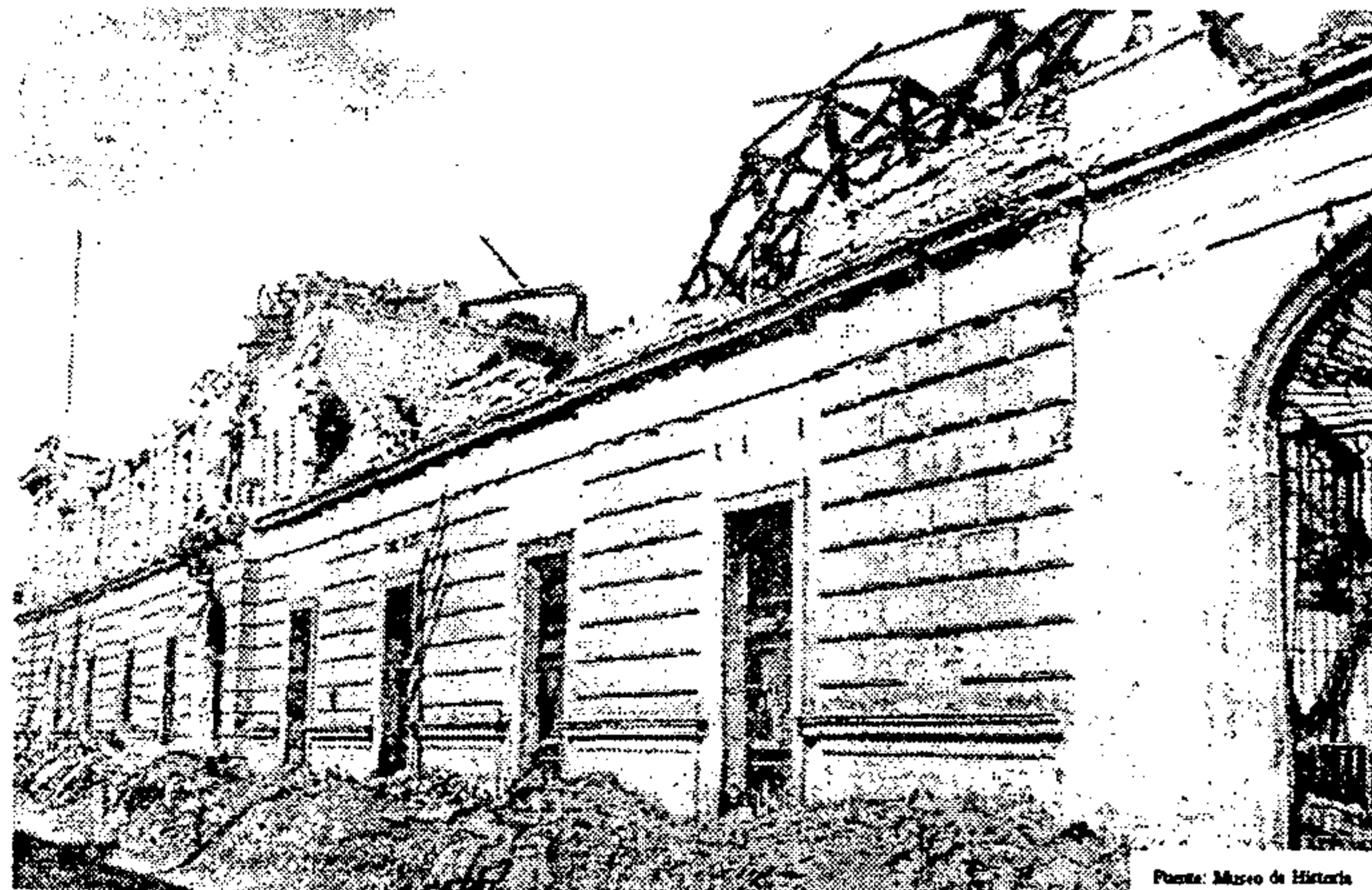
Fotografía No. 24: Dirección General de Correos y Telégrafos, con los daños post-terremotos 1917-18 360
