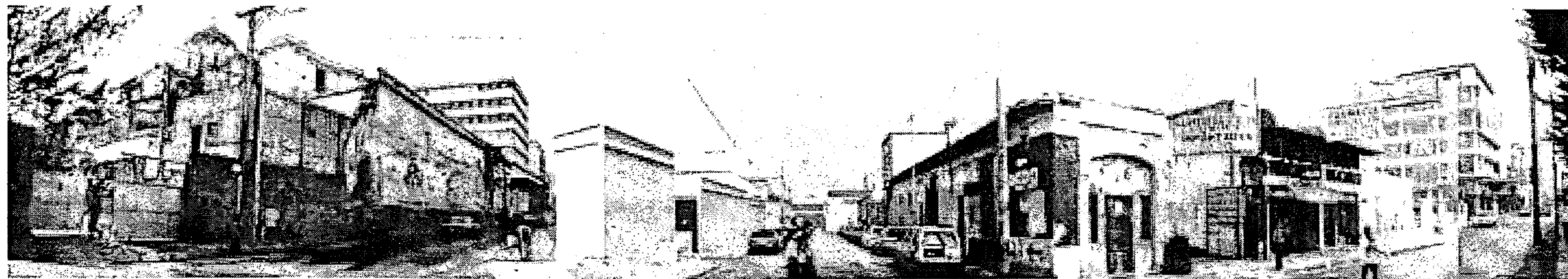
Fotografía No. 61: 7ª avenida
