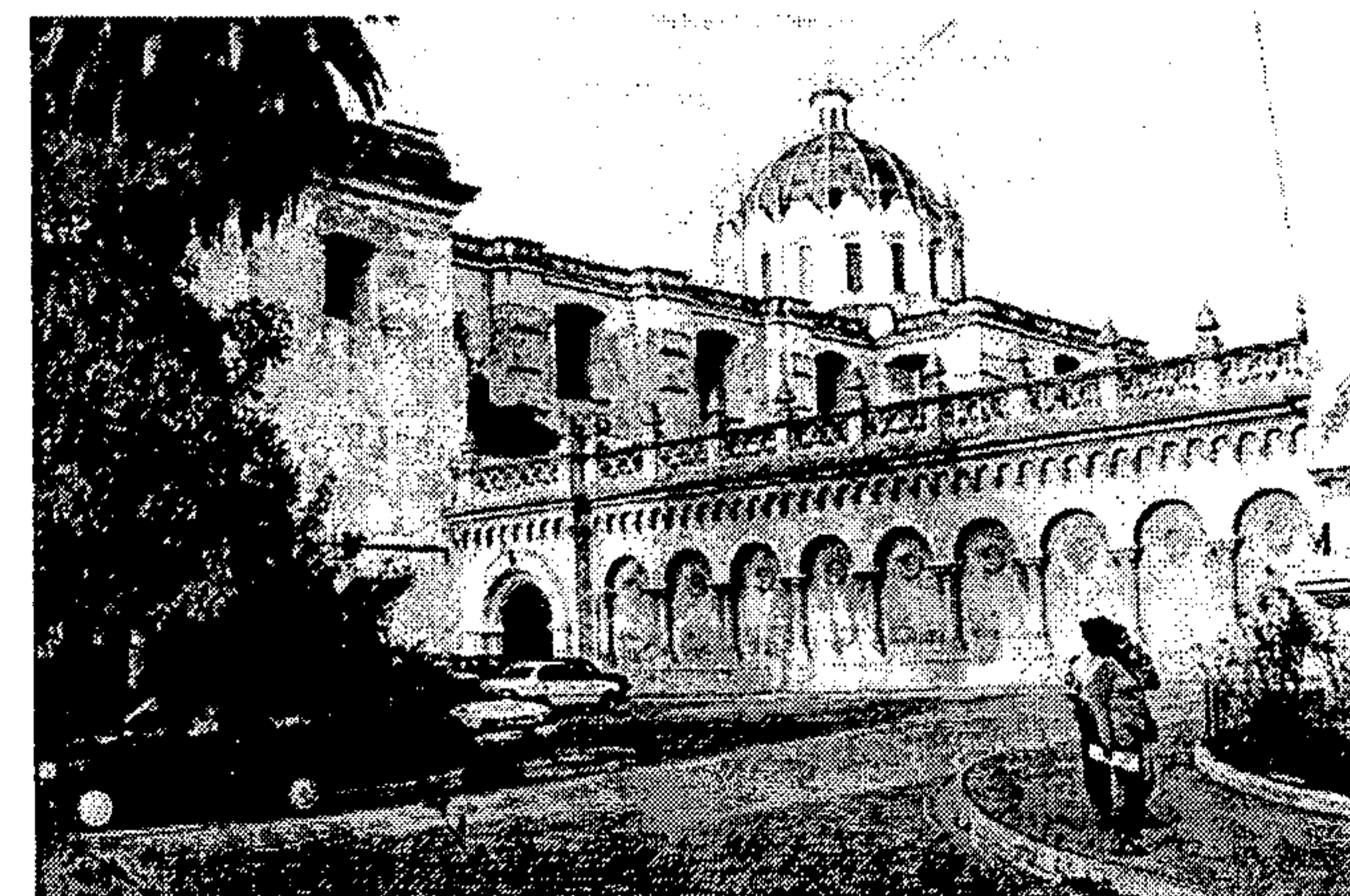
Fotografía No. 80: parte sur del templo Junto al Palacio de la Policía Nacional Civil, se evidencia en los muros del templo franciscano la acción de la humedad en los muros
