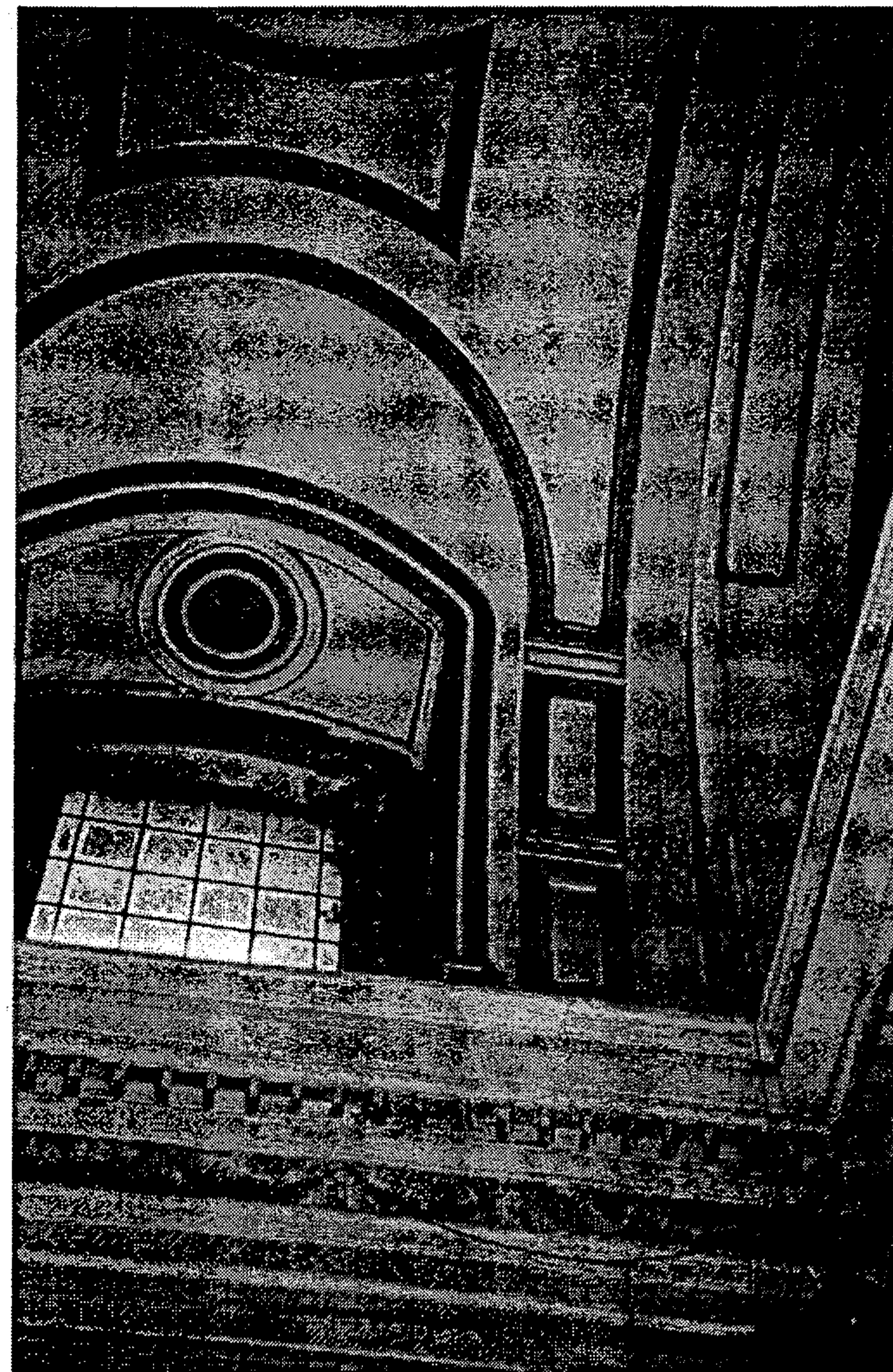
Fotografía No. 110: ventana interior del templo
