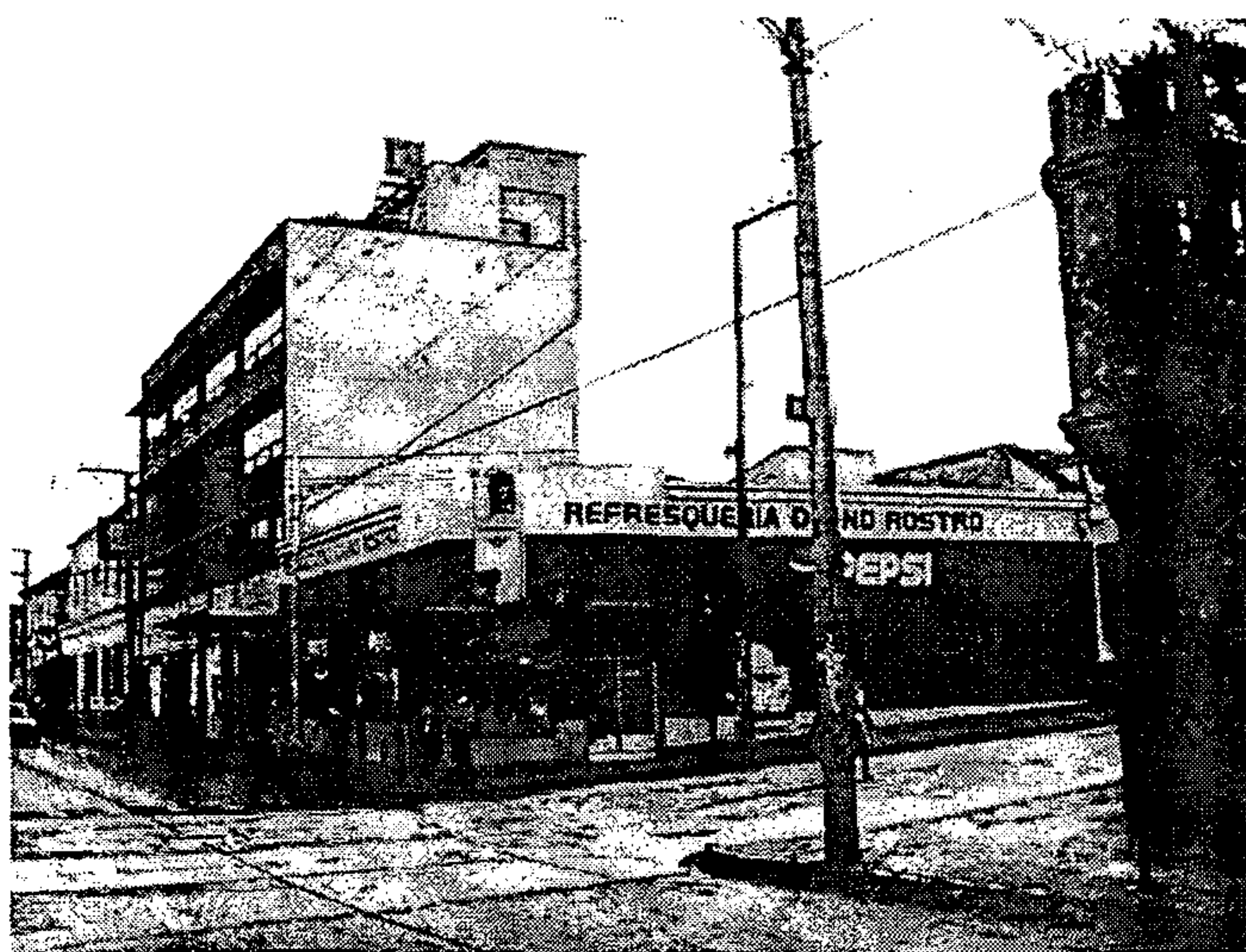
Fotografía No. 57: 14ª. calle y 7ª. avenida Al lado derecho el muro que bordea el área donde estuvo el exconvento. Se evidencia el contraste por escala, estilos, texturas y colores entre las edificaciones
