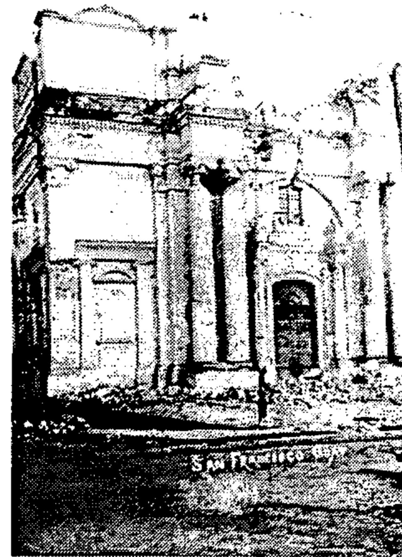
Fuente: Museo de Historia Fotografía No. 15: templo de San Francisco, con los daños post-terremotos 1917-18 351
