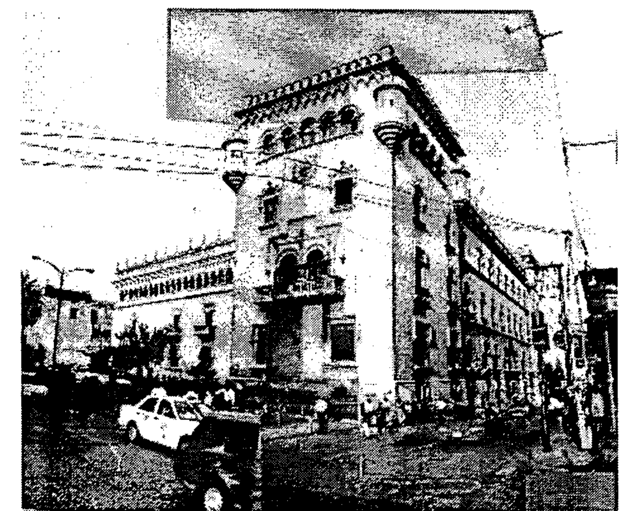
Fotografía No. 55: Palacio de la Policía Esquina de la 6ª. Avenida y 14ª. Calle, donde es evidente la cantidad de alambrado aéreo, de comercio y deterioro en general de la infraestructura urbana, entre los que destaca el pavimento
