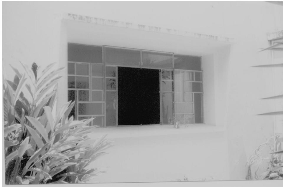
Foto No. 10. 1era. Fase Constructiva. Indicando detalle de remate de ventana.
