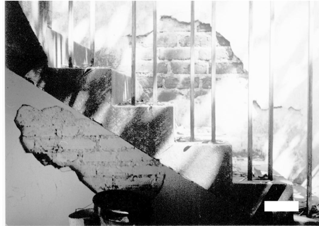
Foto No. 20 Desprendimiento de acabados y herrería corroída.
