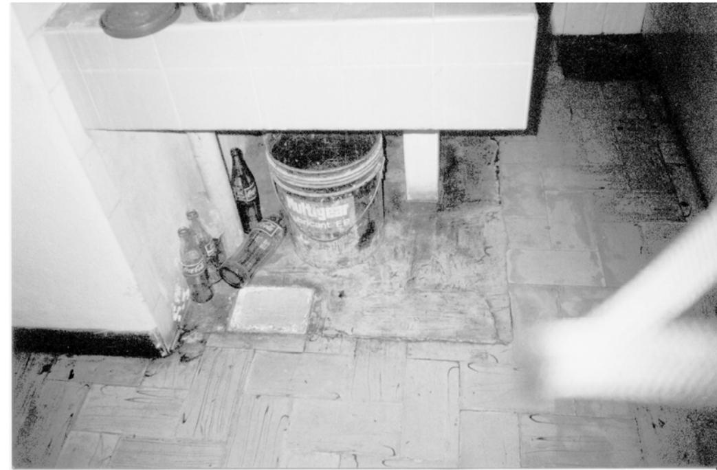
**Foto No. 24** Humedad causada por drenajes en mal estado.
