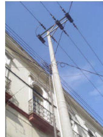
Fotografía 26. Poste de concreto de tendido eléctrico. 10 calle entre 11 y 12 avenida. Autor David Rosales, 2003.
