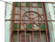
Ventana inmueble ubicado en la 11 c. 11-21
