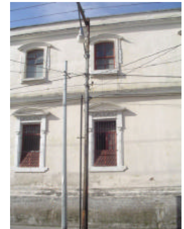
Fotografía 27. Poste de acero con luminaria. 10 calle a un costado de Santo Domingo. Autor David Rosales, 2003.
