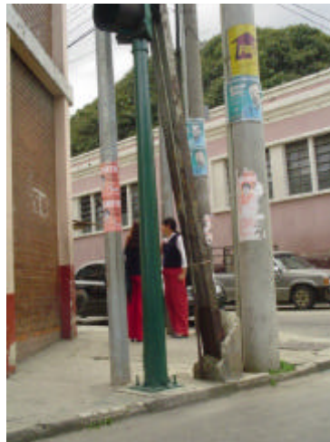
Fotografía 32. Contaminación visual por aglomeración de postes en las esquinas y obstaculización del tráfico peatonal. 12 calle y 11 avenida esquina. Autor David Rosales, 2003.
