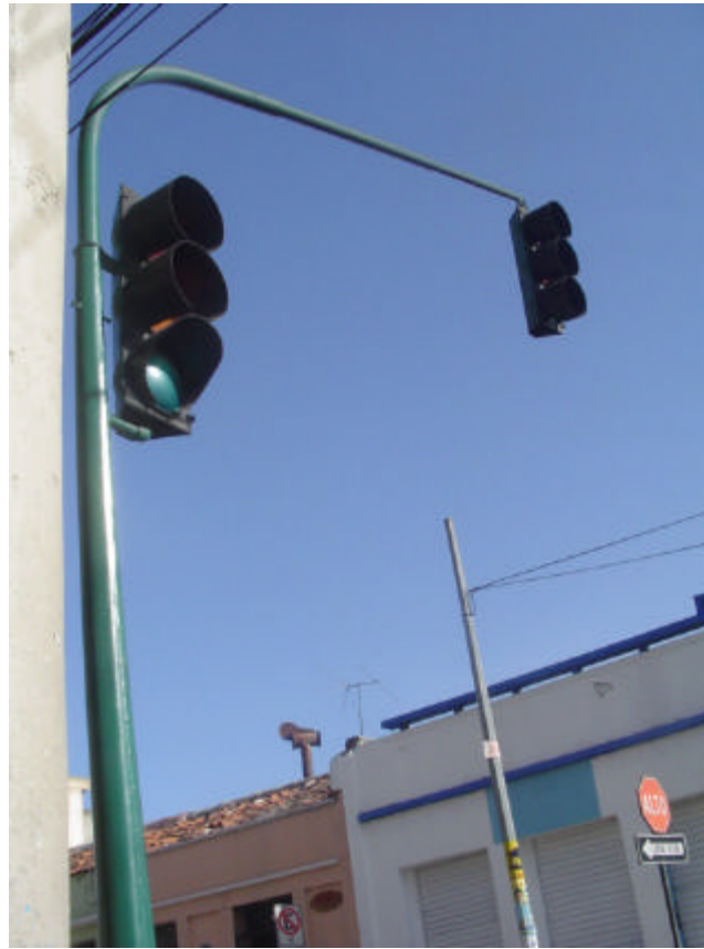
Fotografía 42. Semáforo tipo látigo. Se evidencia la falta de cajas para semáforos peatonales y la falta de señalización que preste facilidades a discapacitados. Autor David Rosales julio 2003.
