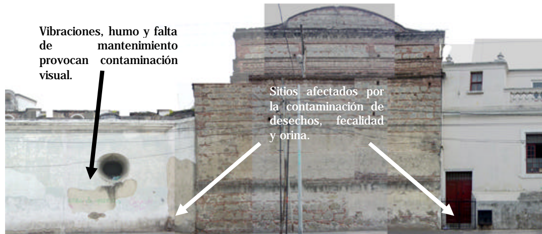
Fotografía 39. 10ª c. sur entre 12 y 13 avenidas, costado iglesia Santo Domingo. La falta de servicios sanitarios dentro del Núcleo provoca que los transeúntes satisfagan sus necesidades fisiológicas en rincones o recovecos generados por las fachadas de los edificios. La falta de mantenimiento de las fachadas provoca su deterioro a causa de los diversos contaminantes atmosféricos, causando contaminación visual. Autor David Rosales, Mayo 2003.
