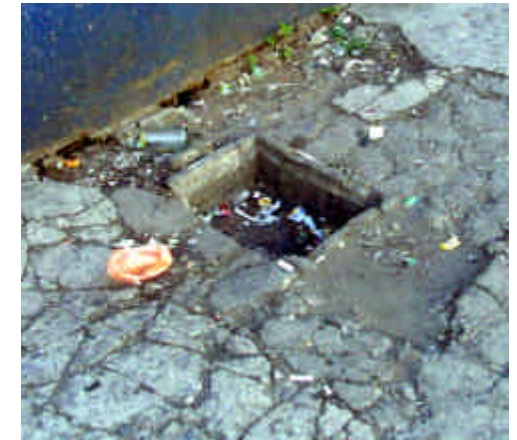
Véase como una caja de registro sin tapadera contamina el ambiente y se constituye en un obstáculo para cualquier peatón.
