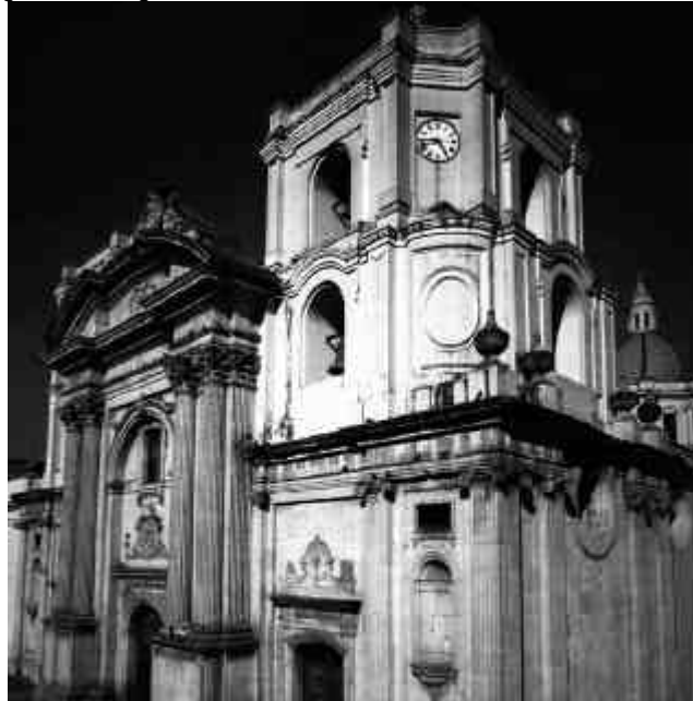
Iglesia La Merced. Estilo arquitectónico neoclásico. Sistema constructivo, mampostería. Mezcla de piedra y barro unida con argamasa hecha basándose en cal, con revestimiento de piedra para cubrir las fachadas.
