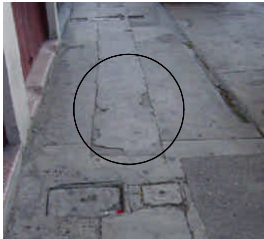
Fotografía No. 13 - Banqueta -
