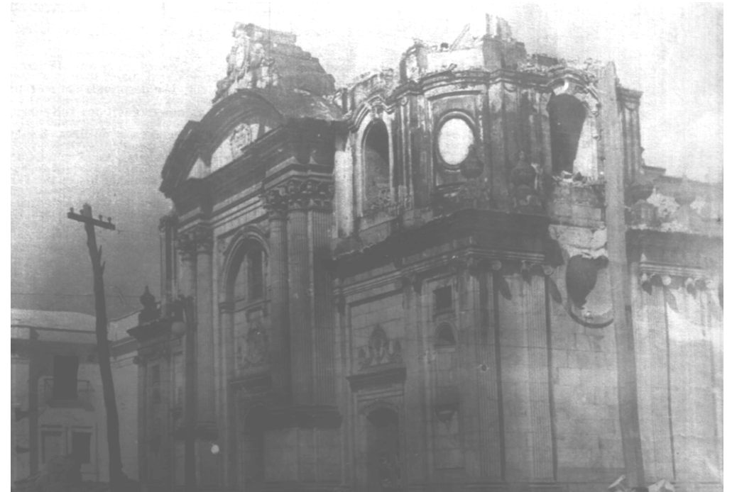
Fotografía No. 4 Iglesia La Merced. Daños por los terremotos 1,917 – 1,918
