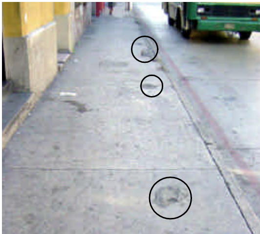
Fotografía No.12 - Banqueta -
