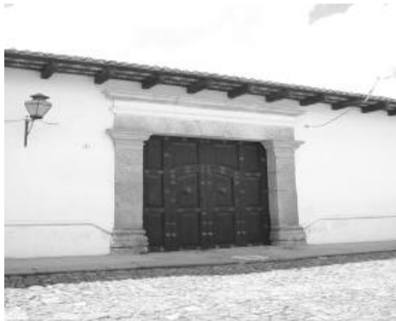
Fotografía No. 51 Puerta con marco de Piedra, Antigua G. Autor: Propia
