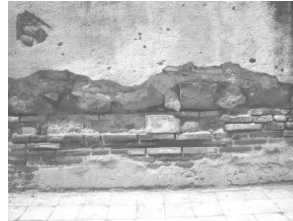
Fotografía No 44 Muro de Piedra y Ladrillo (Calicanto) Autor Propia
