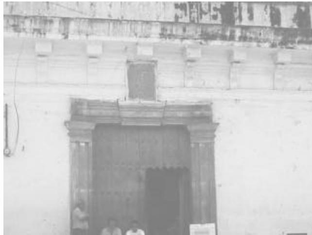
Fotografía No. 50 Puerta con Marco de Piedra, Antigua G. Autor Propia
