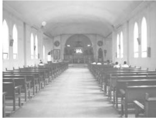
Fotografía No 20 Nave Central con bóveda de cañón, actual Santuario de San Felipe Autor: Propia
