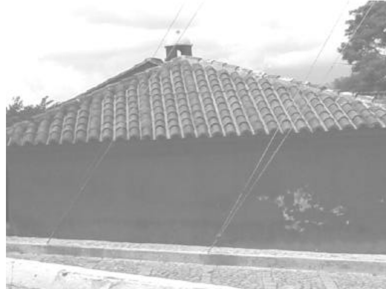
Fotografía No. 46 Techo de lámina de asbesto cemento cubierta de Teja Autor: Propia
