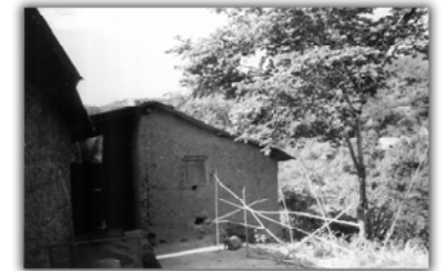
Fotografía No. 6 Tipología de la Vivienda Fuente: Propia
