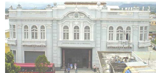
FOTO No. 1 Registro de la Propiedad Inmueble antiguamente edificio de la Corte Suprema de Justicia. 9ª avenida y 14 calle "A" Zona 1
