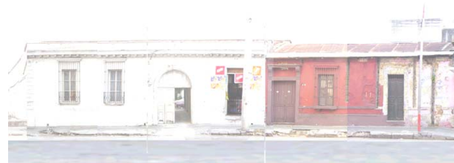
Foto No. 26 Inmueble estilo Colonial Tradicionalista Núcleo Teatro Abril. Ubicada en la 14 calle entre 8ª y 9ª avenida Zona 1
