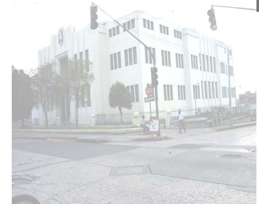
Foto 21,22 Inmuebles de estilística Art-Deco, Núcleo Teatro Abril. Vivienda sobre 14 calle y 9ª Avenida Edificio Sanidad Pública 9ª avenida
