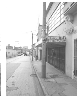
Foto No. 11 Postes de Alumbrado Público 14 calle entre 8 y 9ª avenida
