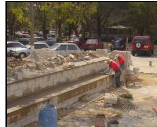
Construcción y Operación de la obra
