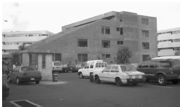
Foto No. 14 Fotografía del edificio de laboratorios campus del CUM.
