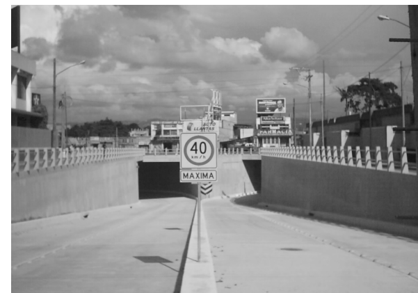
Foto No. 11 Vista parcial del paso a desnivel sobre la 13 calle, zona 11
