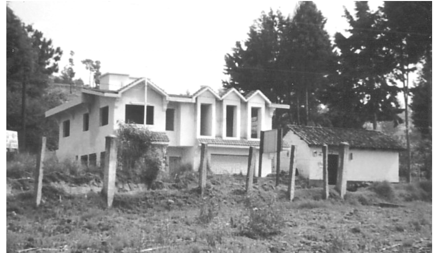
Foto 1: Sistema constructivo de autoconstrucción de viviendas con estilo contemporáneo. Año 2004.
