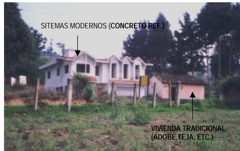
FOTO no. 11. Edificios hacia el suroeste del predio (SW) Nuevas construcciones ya no conservan los sistemas
