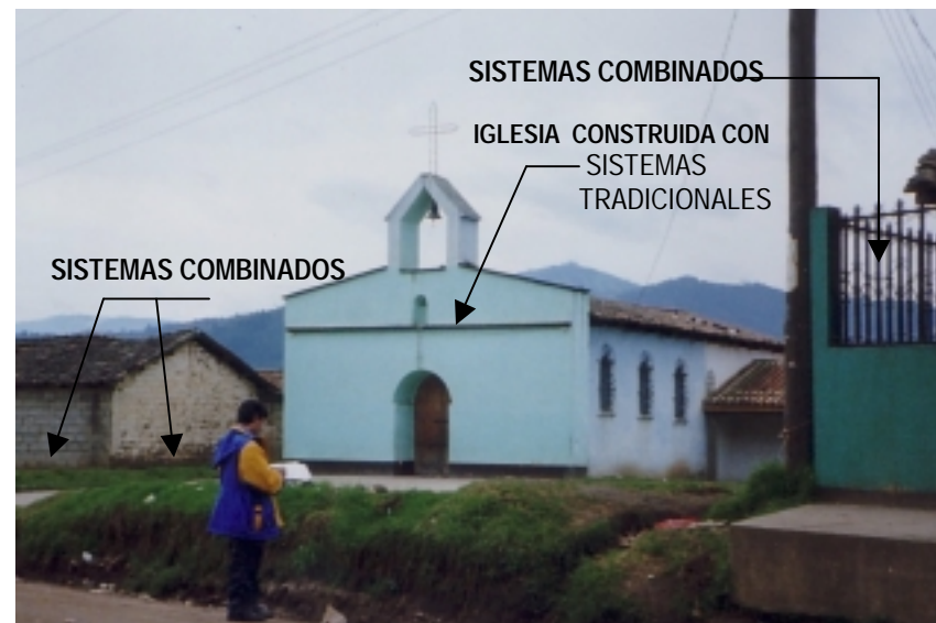
FOTO no. 11. Edificios importantes a 50 metros del predio Se observa una marcada tendencia a construir edificios o ampliaciones con sistemas combinados (mampostería reforzada y adobe).
