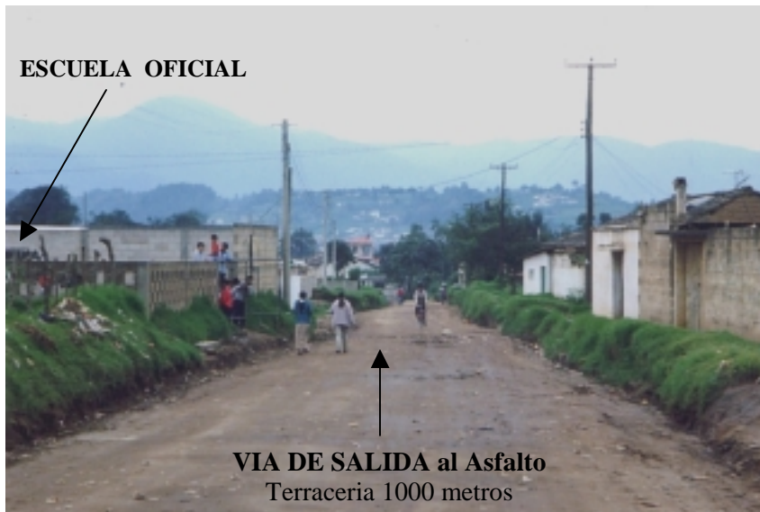
FOTO no. 8. Salida y carretera de asfalto
