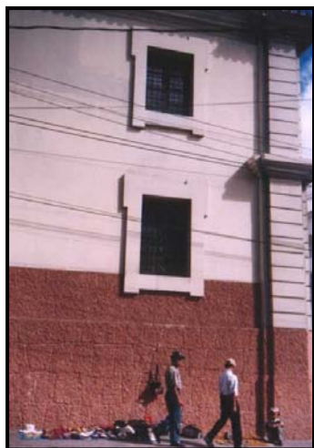
FOTOGRAFÍA No.7 En esta fotografía se puede apreciar claramente el desnivel que posee esta edificación en su parte posterior sobre la 8ª calle. y el zócalo (levantamiento propio)
