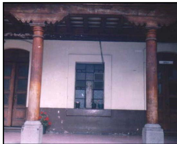
FOTOGRAFÍA No.9 En esta fotografía se puede apreciar que las columnas en su capitel presentan claramente detalles barrocos. (levantamiento propio)
