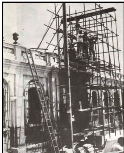
FOTOGRAFÍA No.18 En esta fotografía se aprecia el momento en que se construye el frontón rebajado de piedra del ingreso, el cual colapso a causa del terremoto de 1976.
