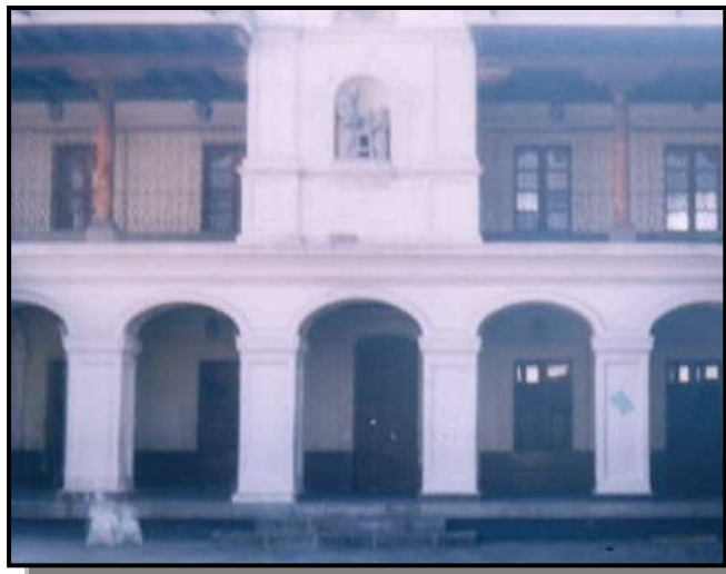
FOTOGRAFÍA No.5 En esta panorámica se observa detalladamente la fachada interior de la edificación. (Levantamiento propio)
