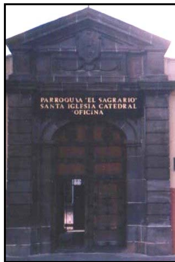
FOTOGRAFÍA No.1 En esta fotografía se observa el frontón rebajado de la puerta de ingreso de carácter monumental. (Levantamiento propio)
