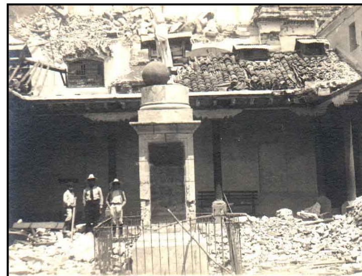
FOTOGRAFÍA INTERIOR: En esta fotografía se pueden apreciar los daños que sufrió el colegio San José de los Infantes a causa de los terremotos de 1917. (Fotografía: Museo de Historia)
