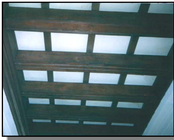
FOTOGRAFÍA No.11 En esta fotografía se puede apreciar detalladamente la imitación de losa española, se observa que la losa es de concreto reforzado y las vigas de madera, son un objeto decorativo. (Fotografía levantamiento propio)
