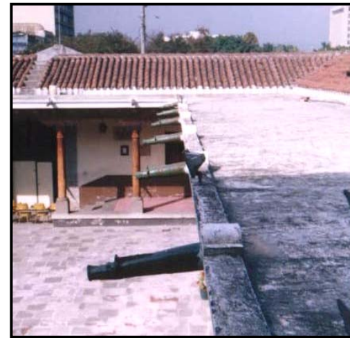
FOTOGRAFÍA No.12 En esta panorámica se observa en detalle las gárgolas que se encargan de la evacuación de las aguas pluviales en la losa del primer nivel. (Fotografía levantamiento propio)
