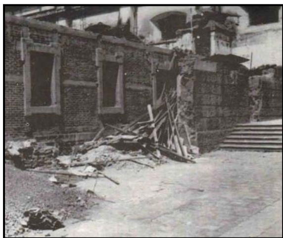
FOTOGRAFÍA No.19 En esta panorámica se muestra el primer nivel de la parte posterior de la edificación, se observa la demolición de la antigua pared de mampostería, la cual es sustituida por un muro de ladrillo y concreto. (Fotografía: Datos históricos del colegio de Infantes 1781-1981)
