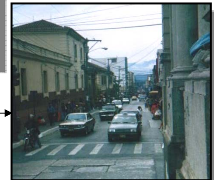
En esta gráfica se observa la contaminación visual provocada por la saturación de postes y cables eléctricos sobre la 7ª Avenida.
