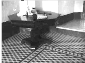
- Detalle del piso de la Sacristía
