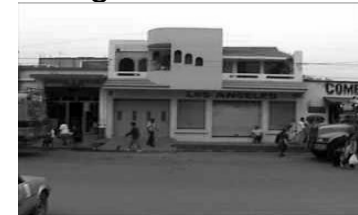
- Cambio de Arquitectura en toda su estructura, acabados y texturas.
