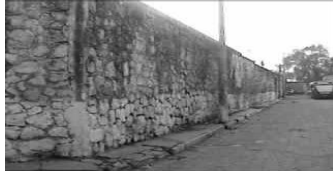
- Muro perimetral casa sacerdotal de la Parroquia de San Juan Bautista
