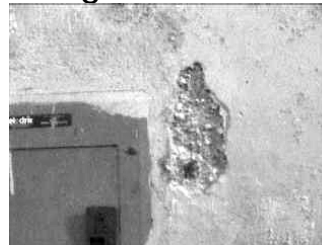
- Transformación distributiva debido a elementos agregados, como cajas
