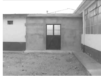
- Intervención de concreto
