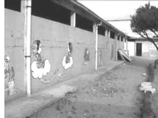
- Vista del corredor de las aulas desde el patio
