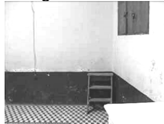
- Closet incrustado en pared de salón sin uso
