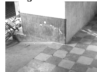
Cambio de piso
