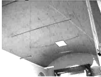
- Vista del techo e iluminación cenital.
